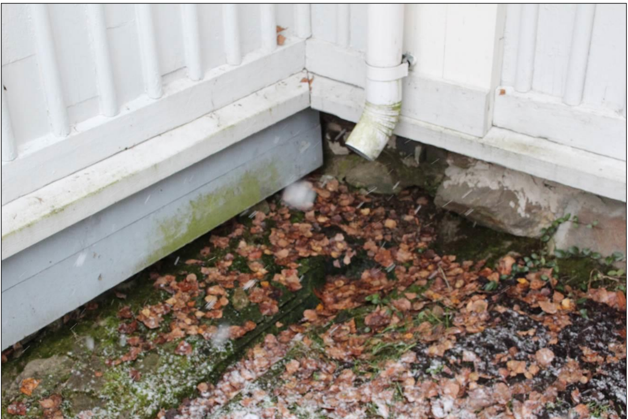
Kuva R6/2. Vesi jää seisomaan syöksytorven alle.
