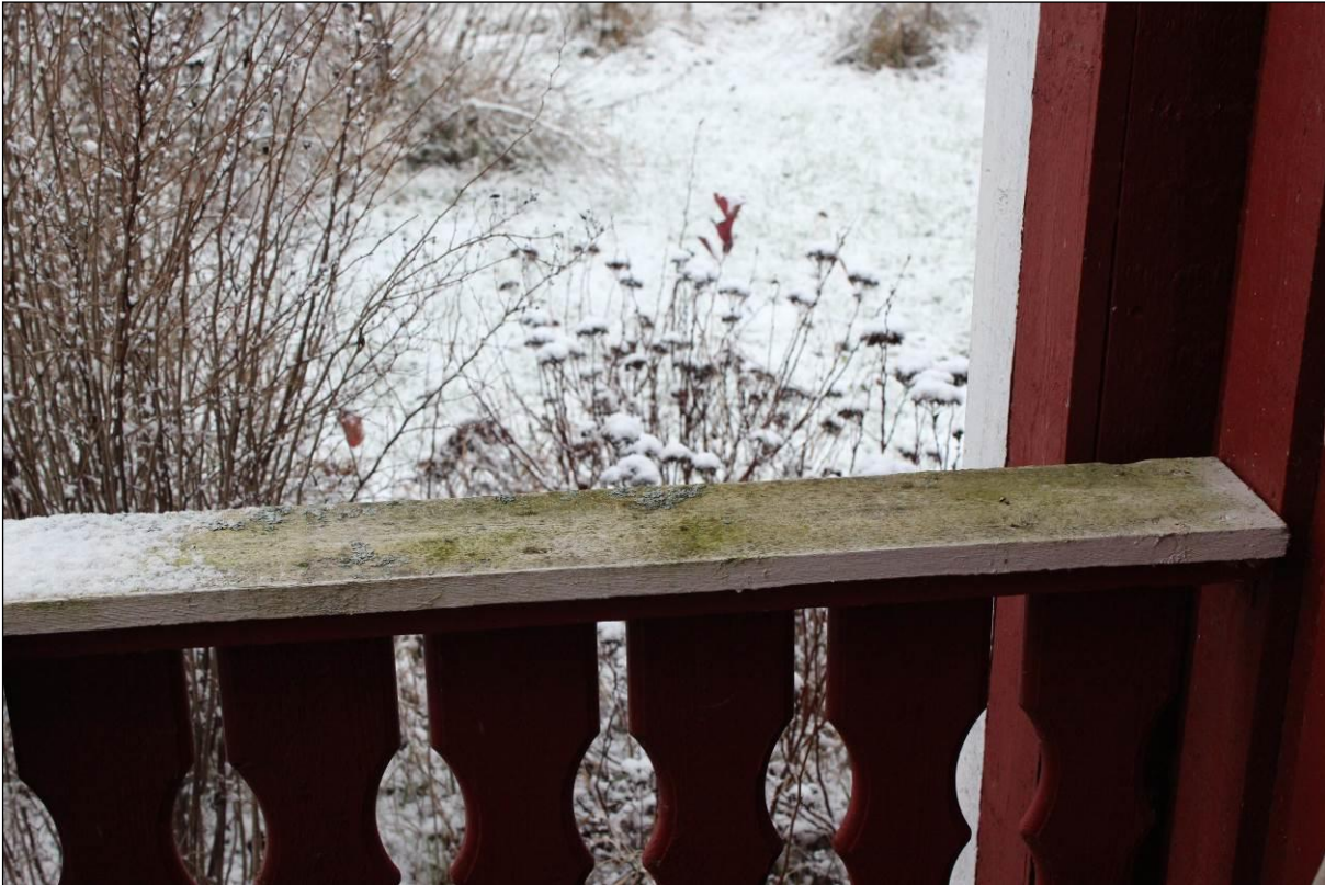
Kuva R3/4. Kaiteen pinta on vihertynyt.
