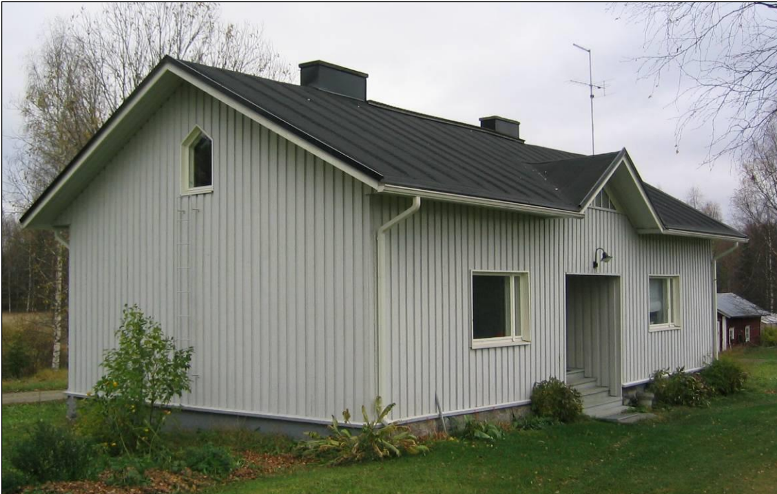
Kuva R4/2. Rakennusrunko on ryhdikäs eikä painumia tai vääntyilyjä ollut merkittävästi näkyvissä.
