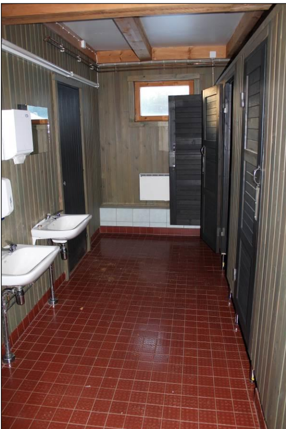
Kuva R5/7. Navetan päädyssä olevat WC-tilat ovat sisäpinnoiltaan hyväkuntoiset.
