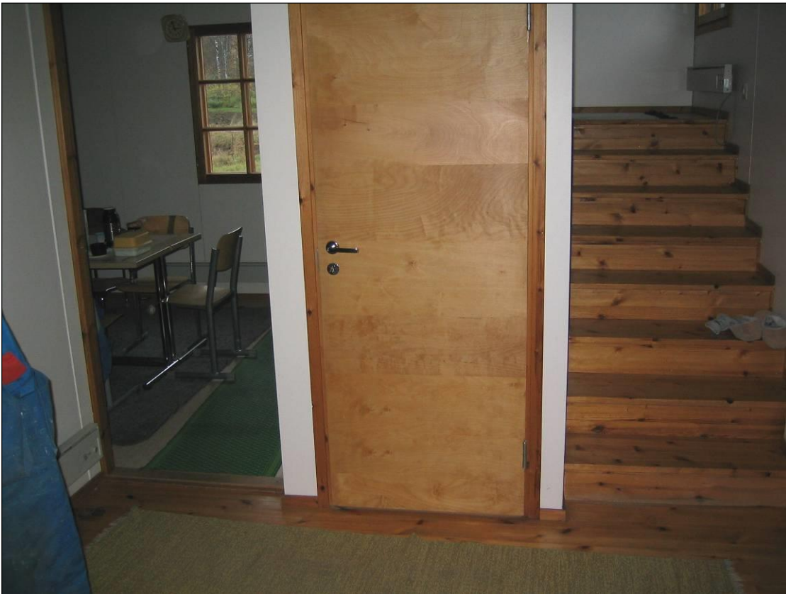
Kuva R3/6. Sisäövet ovat hyväkuntoisia vaneriovia. Seiniä on pinnoitettu lastulevyllä.
