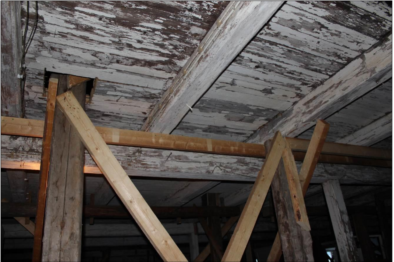
Kuva R5/1. Väli- ja yläpohjaa tuettu.
