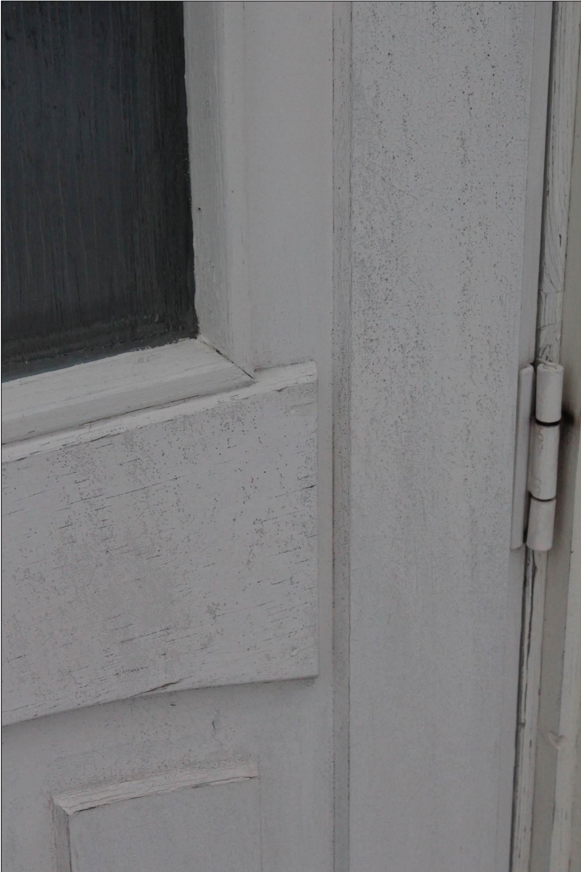
Kuva R6/9. Ulko-oven pinnassa on tummia läikkiä ja uurteita.
