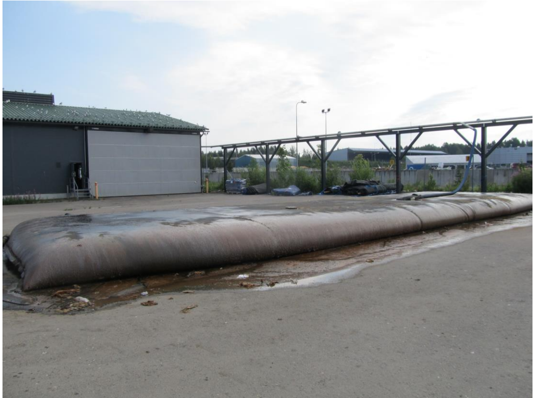
KUVIO 14. 18 m x 4 m geotuubi OILI-aseman takana. Tilavuus 150 m 3 .
