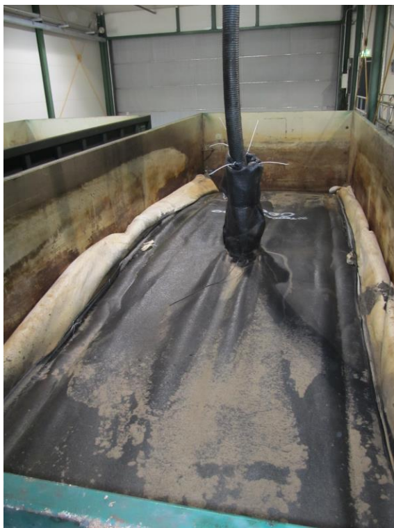
KUVIO 13. Jätelavalle aseteltu geotubi OILI-asemalla. Tuubin tilavuus 15–20 m 3 .
