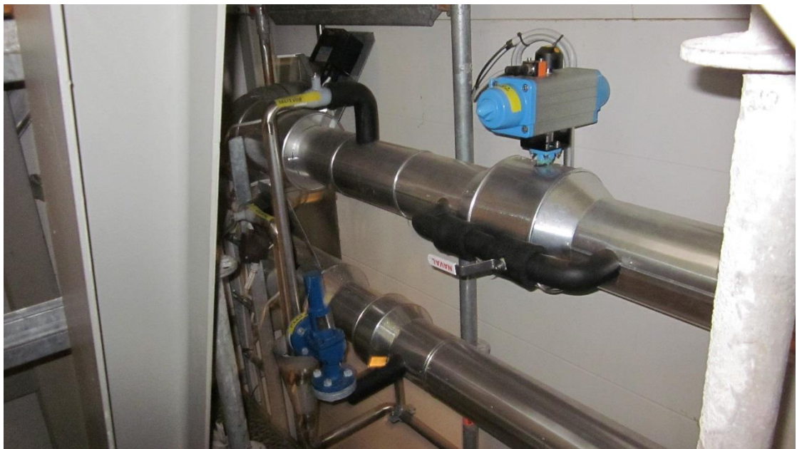
Kuvio 12. Harvesteri 1 jäävesilinjan laitteet
