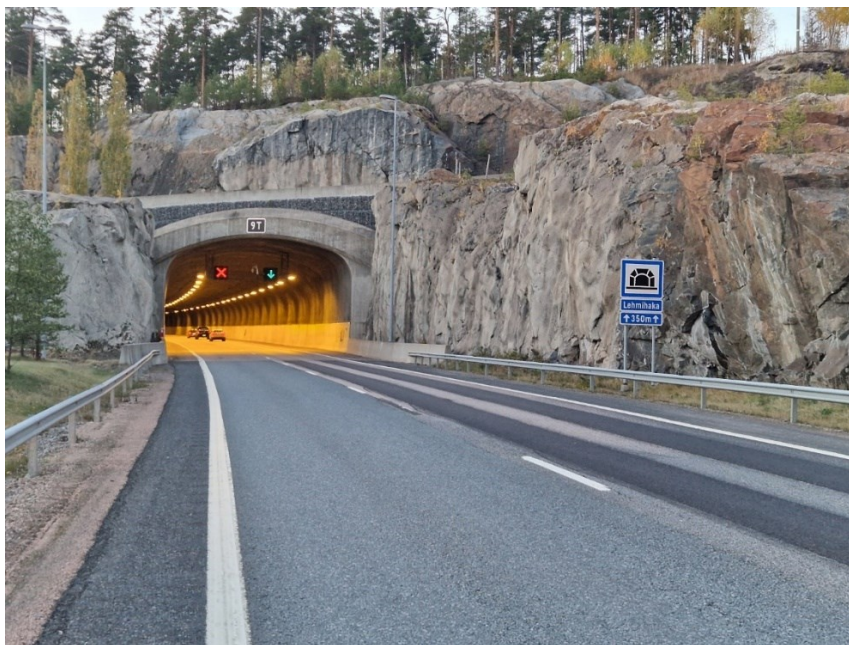
KUVA 8. Lehmihaan tunneli 12.10.2022 kello 18:30, vasemman kaistan sulkusekvenssi käynnissä (Riipiinen).
