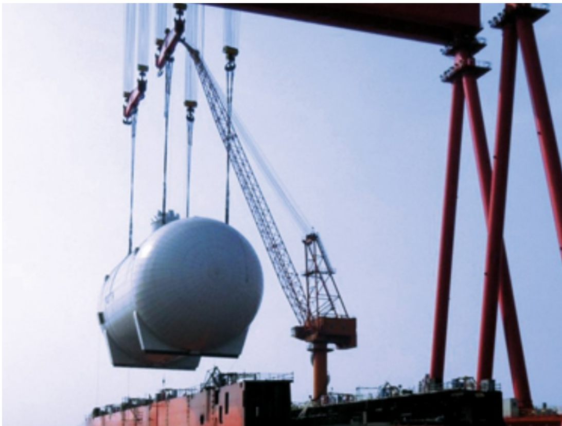
Kuva 3. Tyypillinen sylinterimäinen C-tyyppin tankki (Marine & Offshore, 2021)
