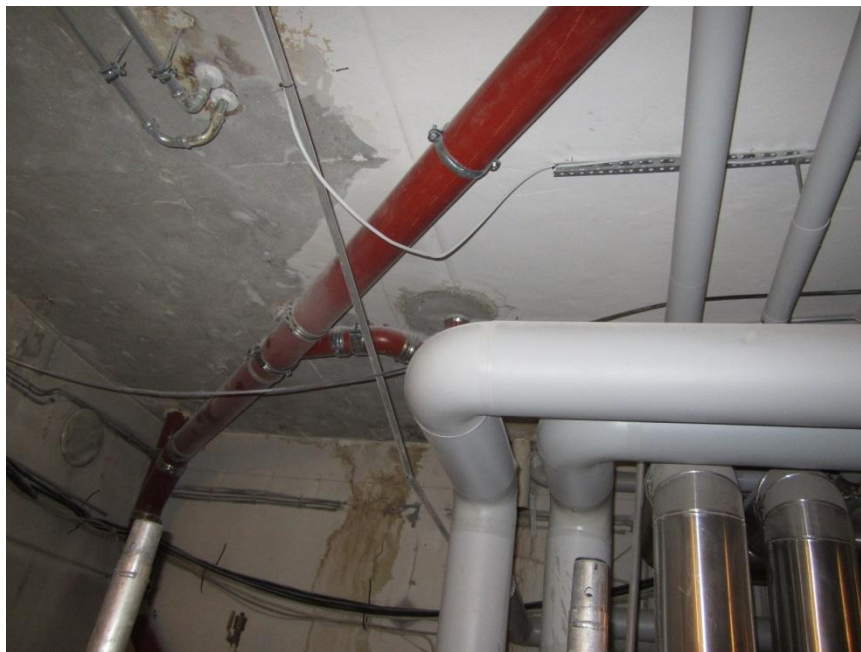
Kuvio 8. Teknisen tilan katon ahtaat putkien välit
