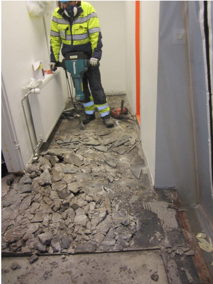
Kuvio 7. Laattojen irrotusta piikkauspäivänä
