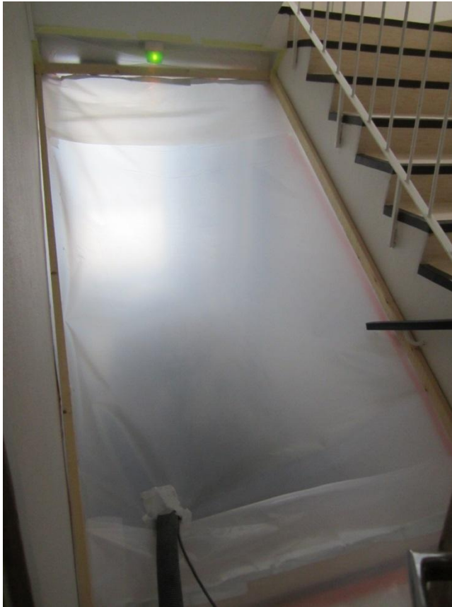
Kuvio 10. Asbestipurkualue rajattuna porraskäytävästä
