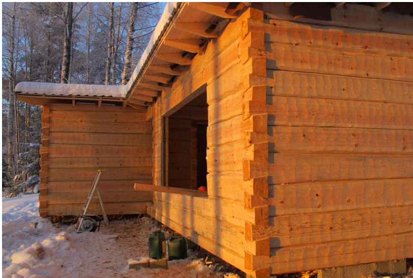
Kuva 1. Suhteellisen moderni pohjan muodoltaan L-mallinen saunatupa. Kuva Hongos - rakennusalayrityksen luvalla [7]
