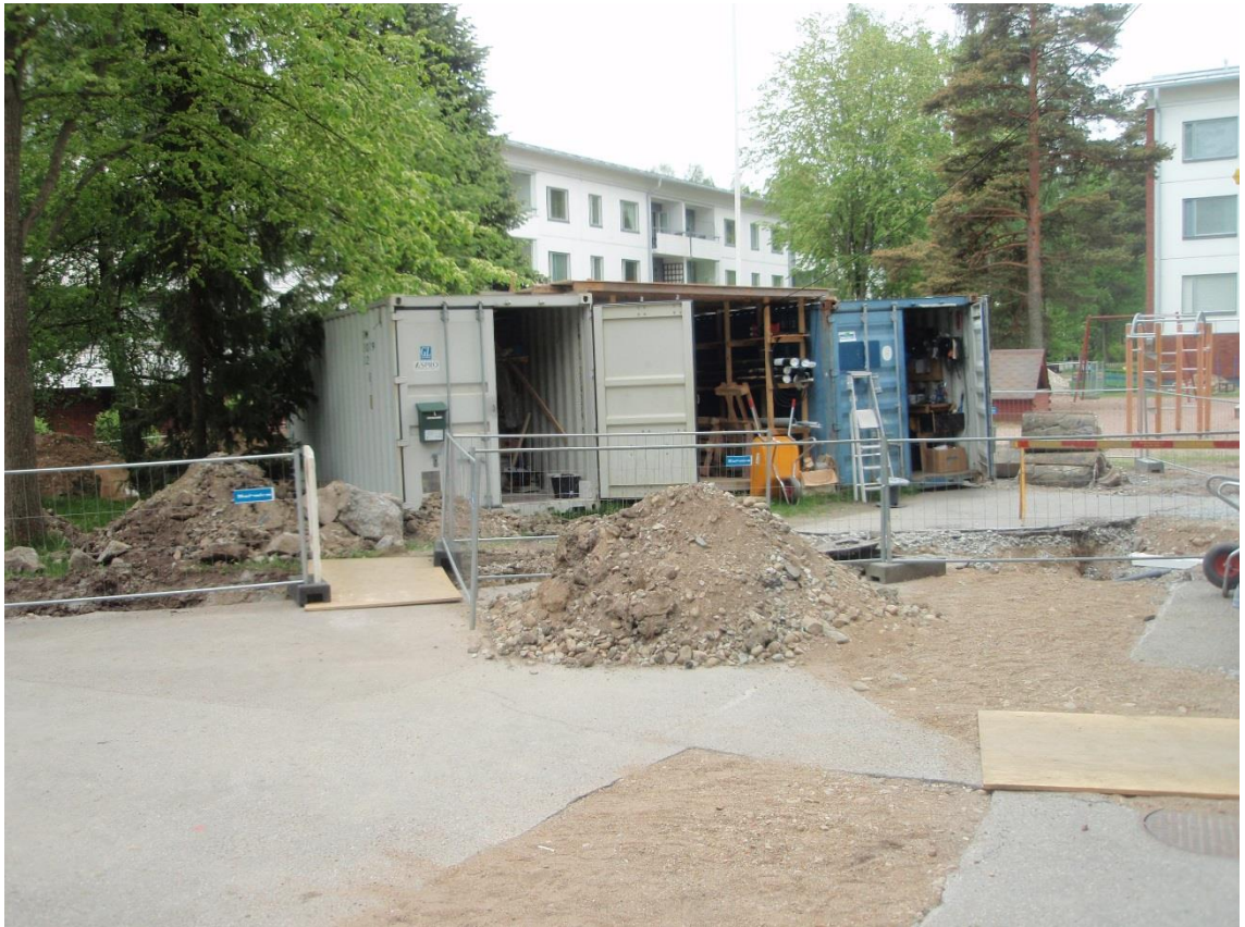
Kuva 12. Työmaan varastokontit sijoitettuina Jaakkimanrinteeseen.
