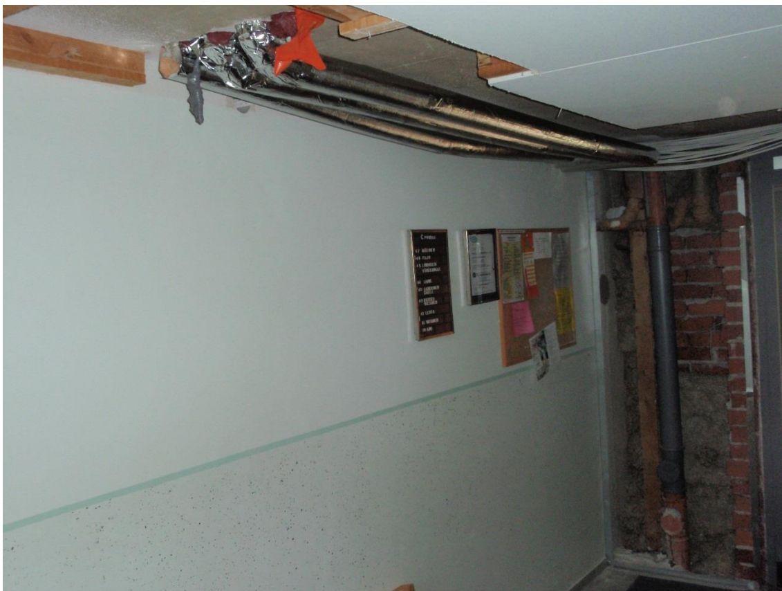
Kuva 5. Purettu kotelo ja uusia vesijohtoja Jaakkimanrinteessä.
