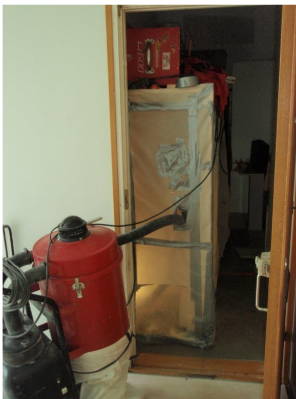
Kuva 7. Kylpyhuoneen purku on käynnissä. Suojamuovikehikon päällä on alipaineistaja.
