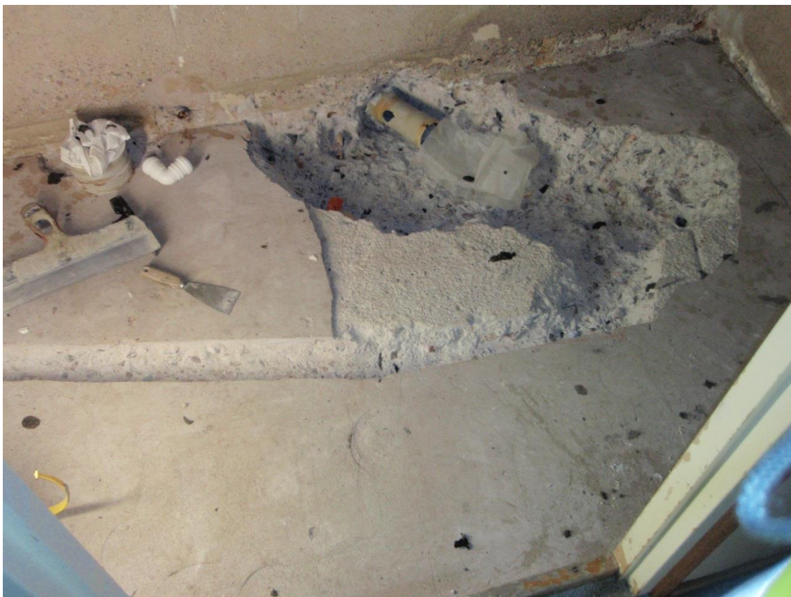
Kuva 6. Purettu kylpyhuone ja lattian viemäriroilo Jaakkimanrinteessä.
