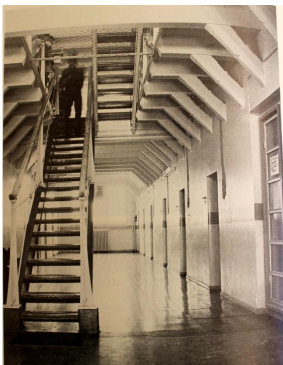
Kuva 15. Kuva ensimmäisen kerroksen käytävältä jolloin välipohjat olivat vielä avonaiset. (Karvonen 1985)
