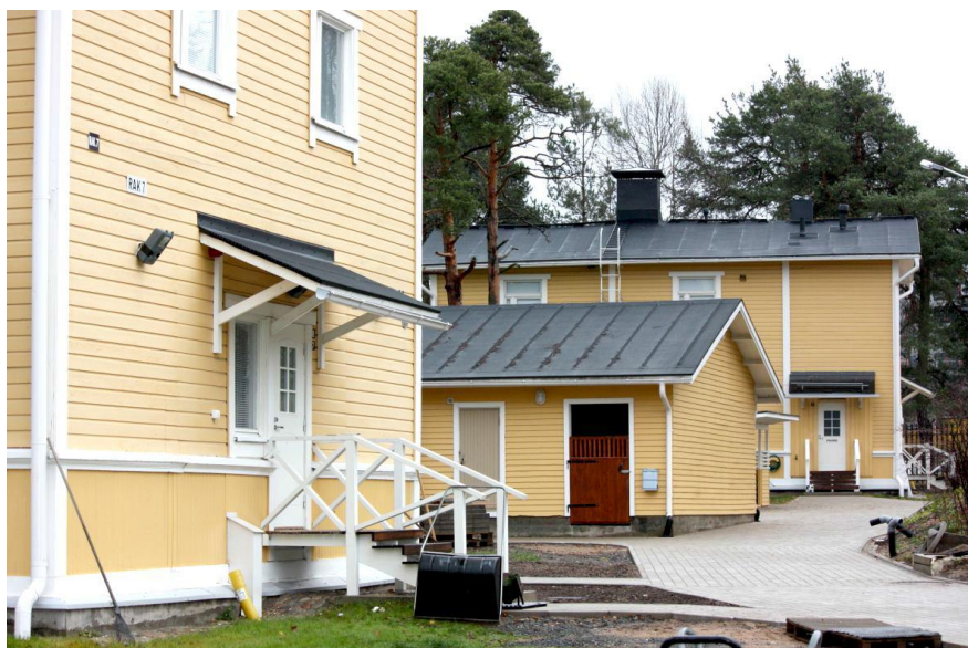
Kuva 21. Henkilökunnan hirsirunkoiset asuinrakennukset on rakennettu 1900- luvun taitteessa ja saneerattu v. 2012 vankien vapauttamisyksikön käyttöön. (Rikosseuraamusvirasto.)
