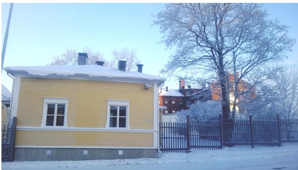
Kuva 22. Näkymää Nahkatehtaankadulta vankila-alueelle päin. Kuvassa vasemmalla vanhan putkarakennuksen päätyseinää.
