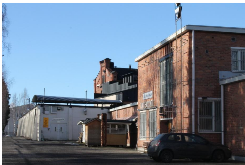
Kuva 16. Vuonna 1963 rakennettua työliikesiipeä kuvattuna koillisesta 2014.
