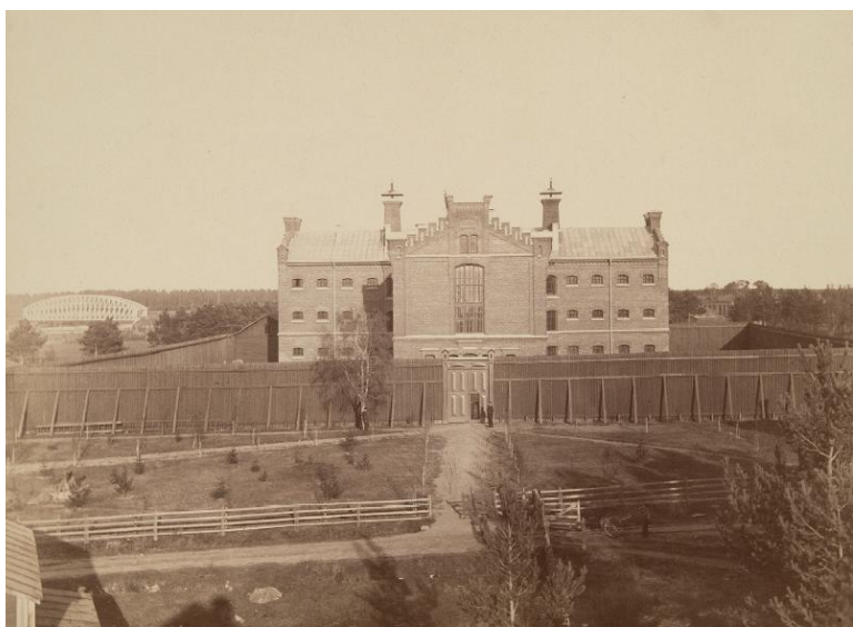
Kuva 9. Oulun uusi lääninvankila 1890-luvulla ympärillään hirsirakenteinen piiraita (Museoviraston kuvaarkisto).
