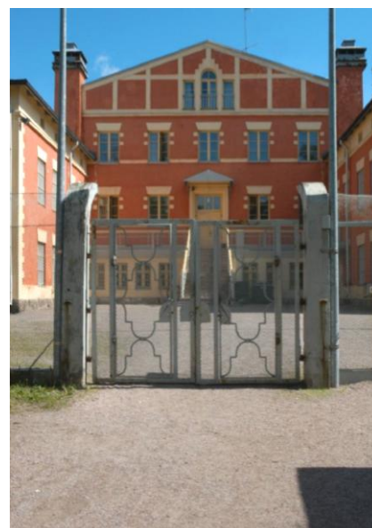
Kuva 4. Keravan nuorisovankilan päärakennus suunniteltiin Yleisten rakennusten ylihallituksessa arkkitehti Florentin Granholmin johdolla ja toteutettiin 1888–1890. (Rikosseuraamusvirasto)
