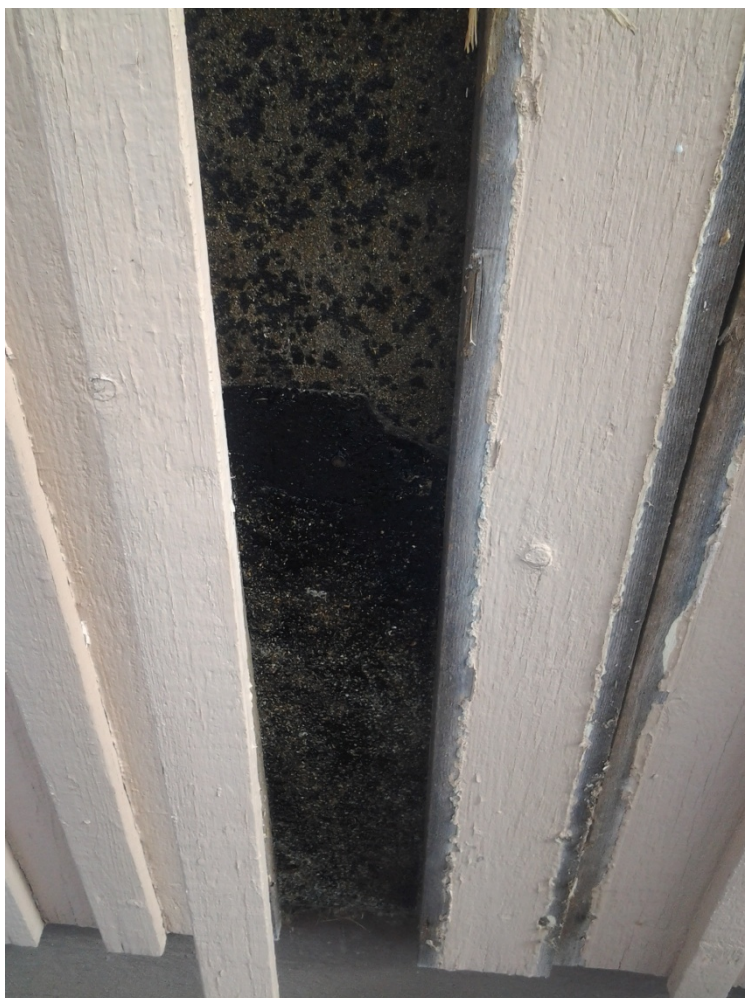
Kuva 4. Bitumihuopa verhouksen takana
