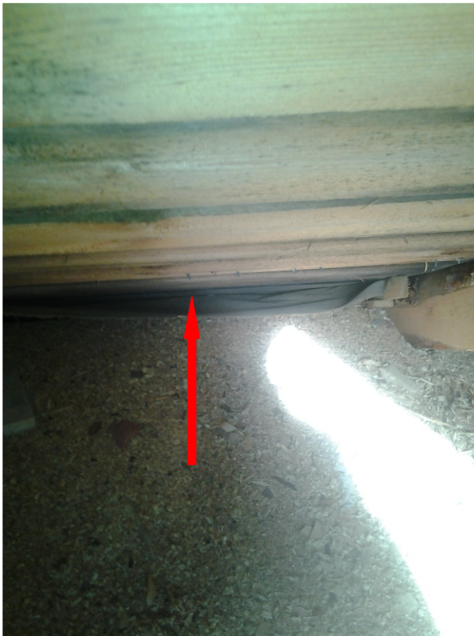
Kuva 2. Tuuletusrako ummessa
