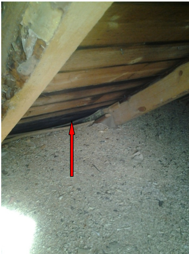
Kuva 12. Tummentumia kattopohjassa
