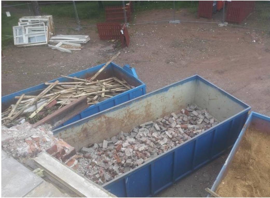
Kuva 9: Purkujätteiden lajittelua työmaalla
