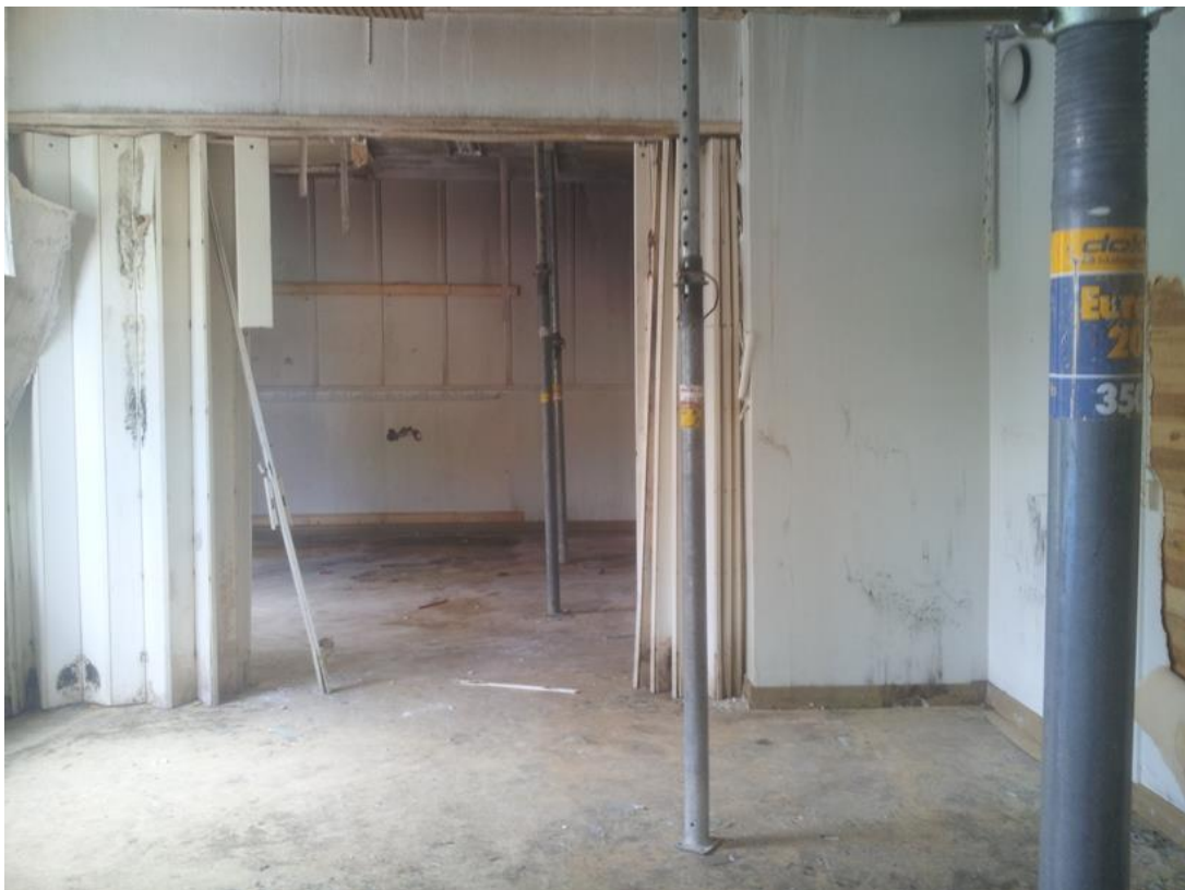
Kuva 7: Välipohja tuettu ja sisätilat siistitty
