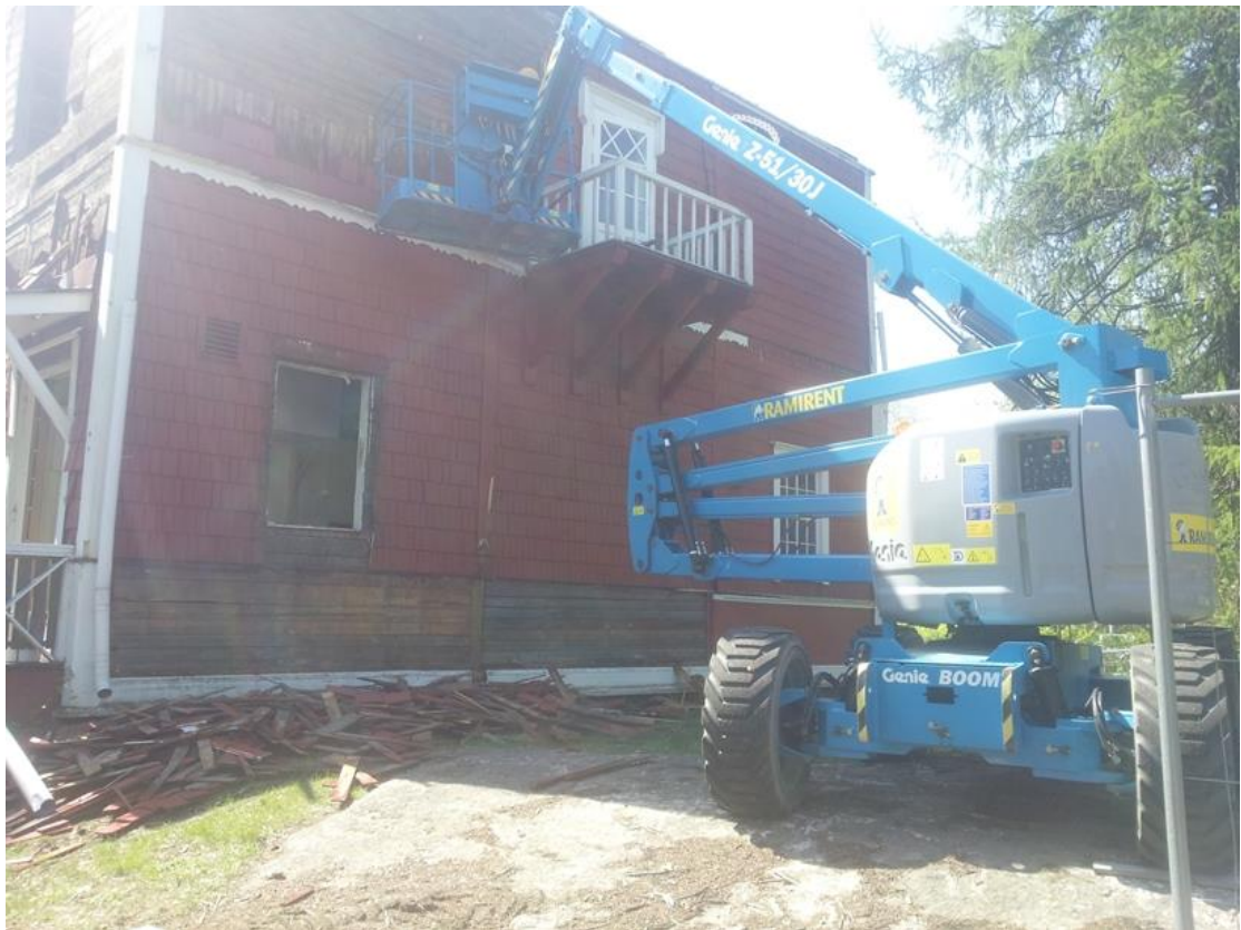
Kuva 8: Paanujen irrotusta henkilönostimesta käsin
