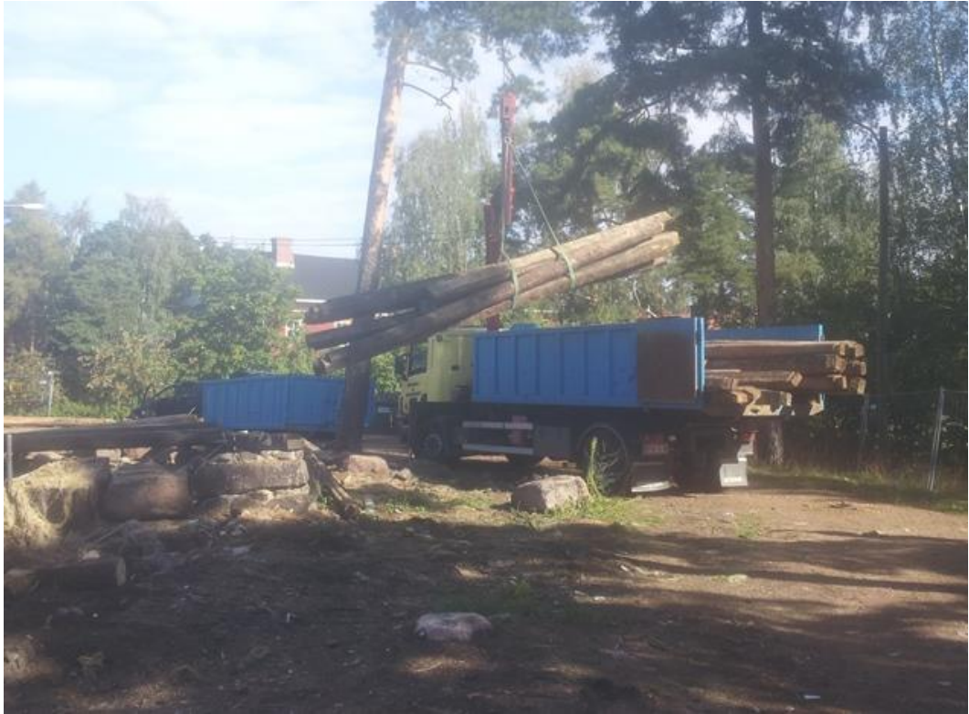
Kuva 11: Hirsinippujen noutoa Ekotallille myyntiin
