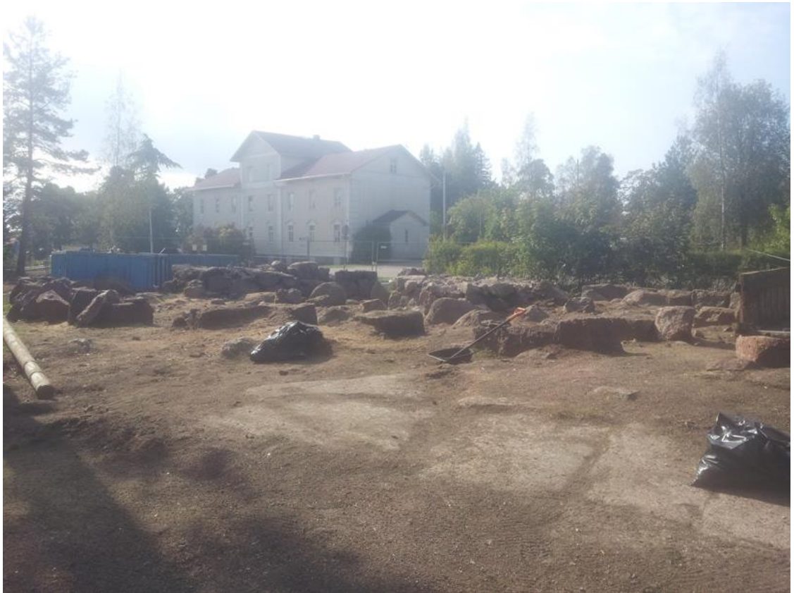
Kuva 12: Työmaan loppusiivous käynnissä, peruskivet jätettiin paikoilleen
