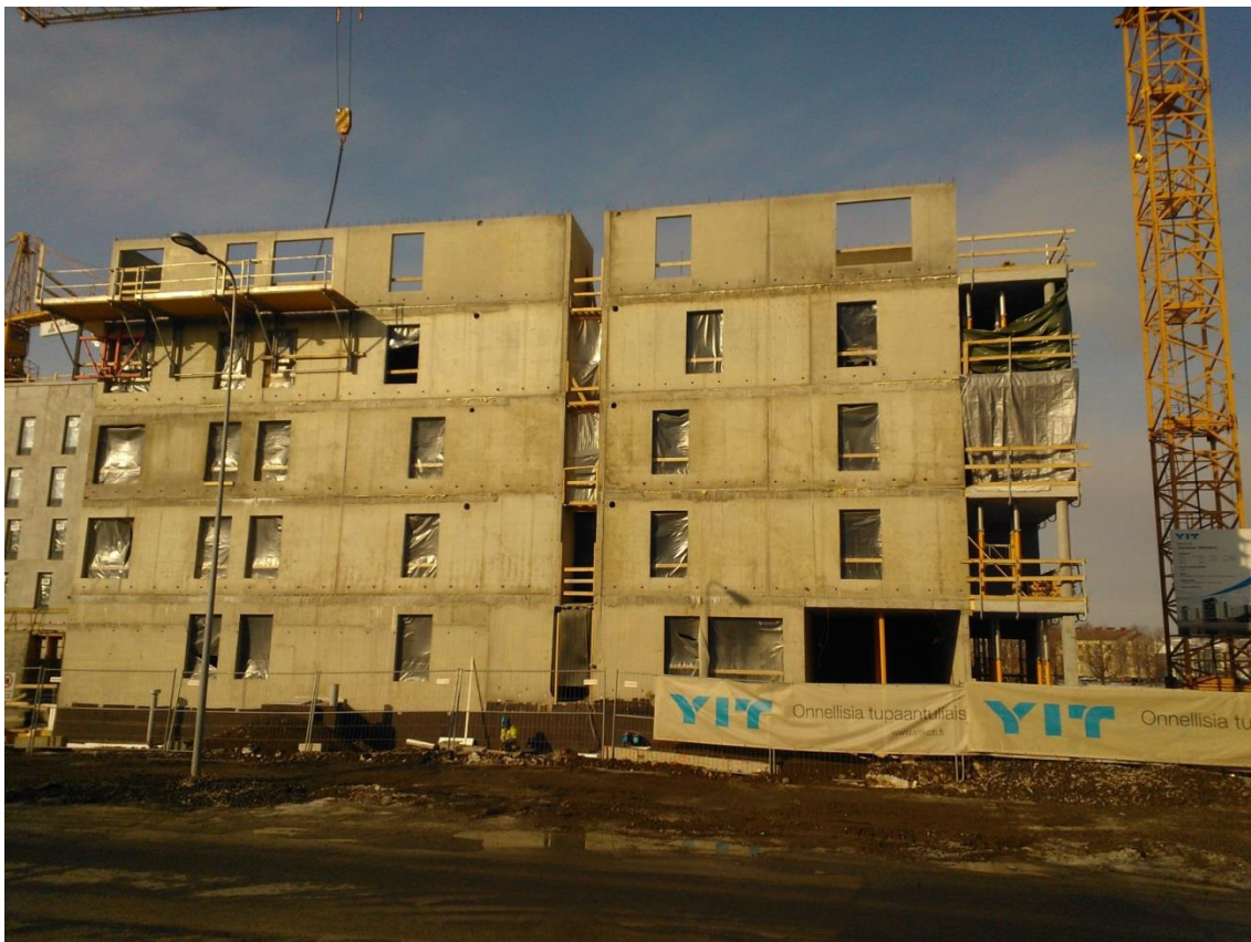
Kuva 1. YIT Rakennus Oy:n toteuttaman As Oy Joensuun Rantakiven betoni-runko
