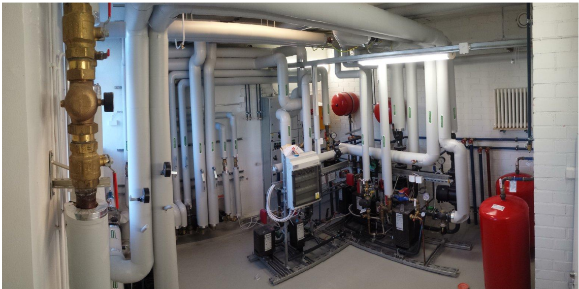
Kuva 7. Dickursby Skolan lämmönjakohuone
