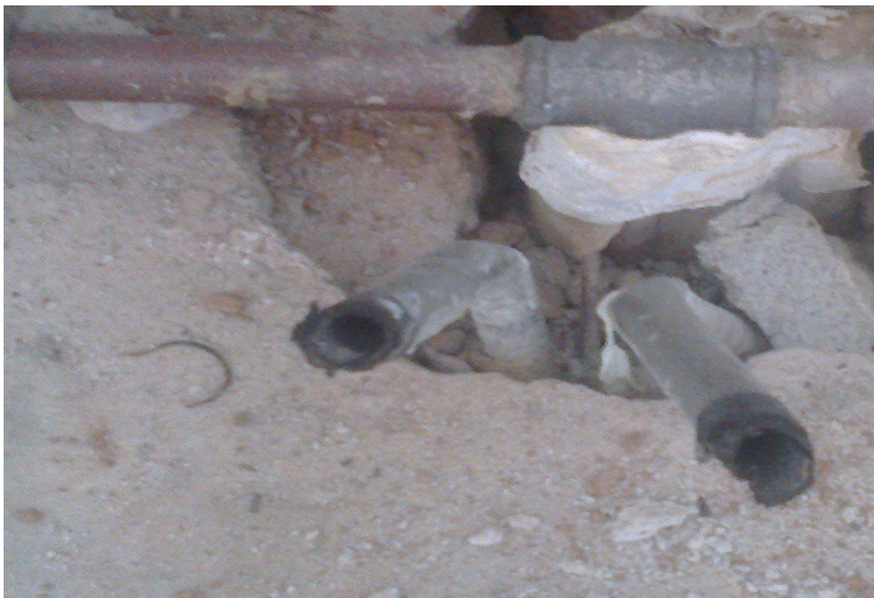
Kuva 15 kreosoottipitoista sähköputkien eristettä
