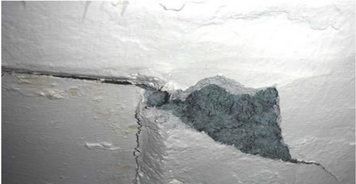
Kuva 6 Ilmanvaihtokanavaan ruiskutettua sinistä asbestia (1, s. 4)
