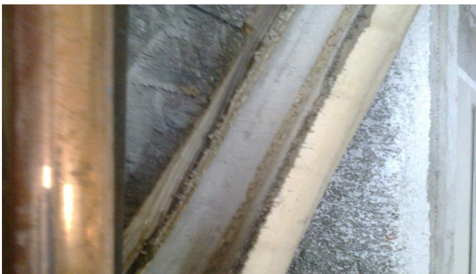
Kuva 12 Pahvilla päällystetty asbestieriste
