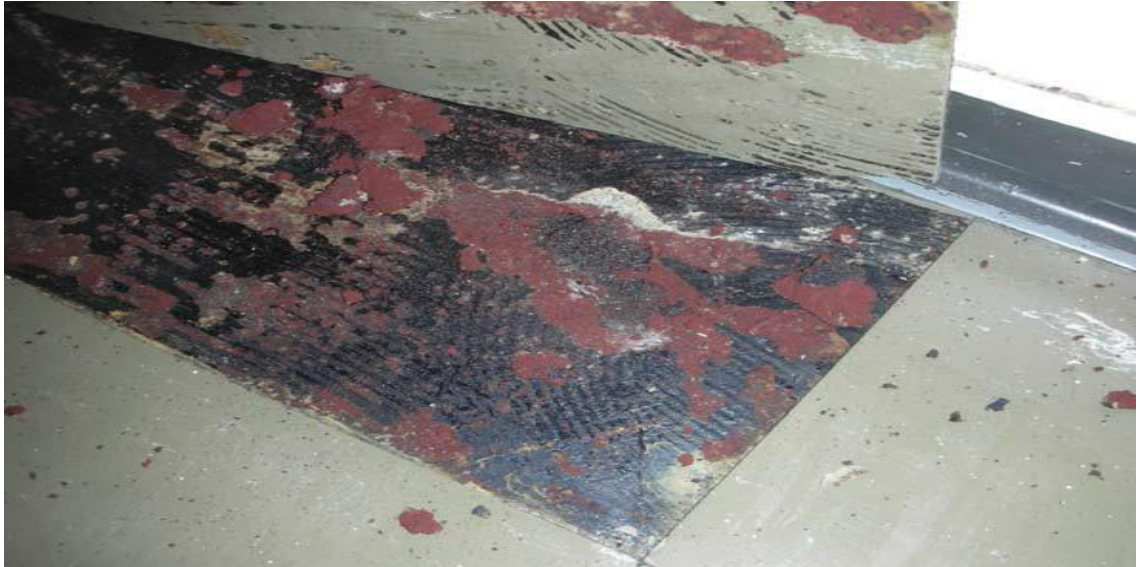
Kuva 5 Asbestipitoinen vinyylilaatta liimattu asbestipitoisella mustalla liimalla (1, s. 7)
