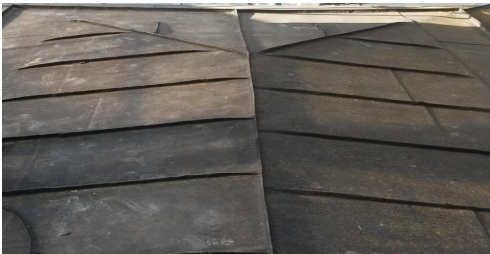
Kuva 10 Asbestipitoinen vesikaton pinnoite
