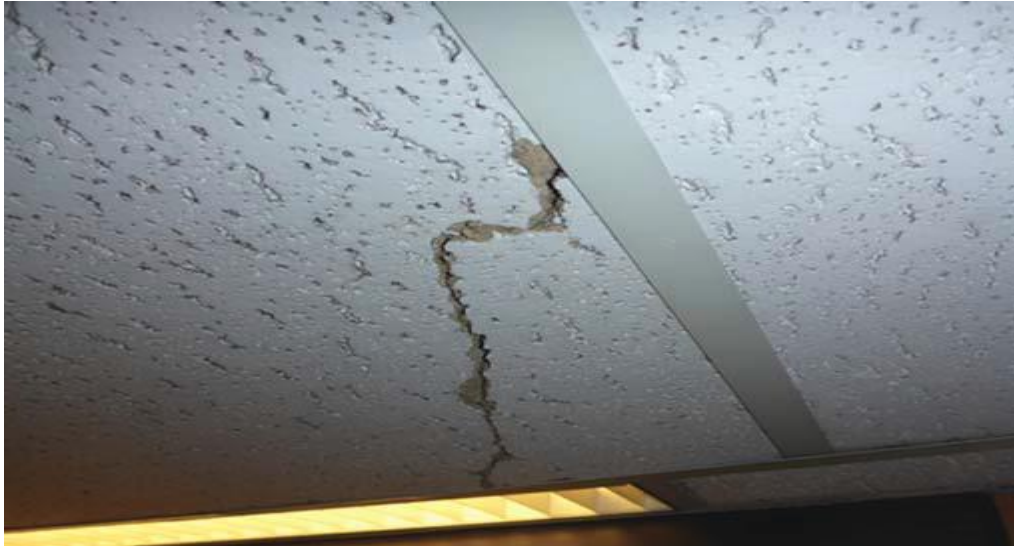
Kuva 3 Asbestipitoinen akustiikkalevy alakatossa (1, s. 6)
