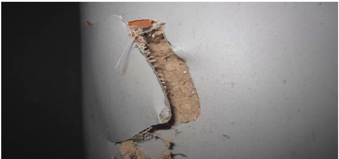
Kuva 4 Asbestipitoinen putkieriste päällystetty uudella muovilla (1, s. 5)
