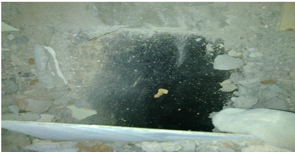
Kuva 11 Asbestipitoista vinyylilaattaa ja mustaa asbestipitoista liimaa tekniikkakuilujen sisällä
