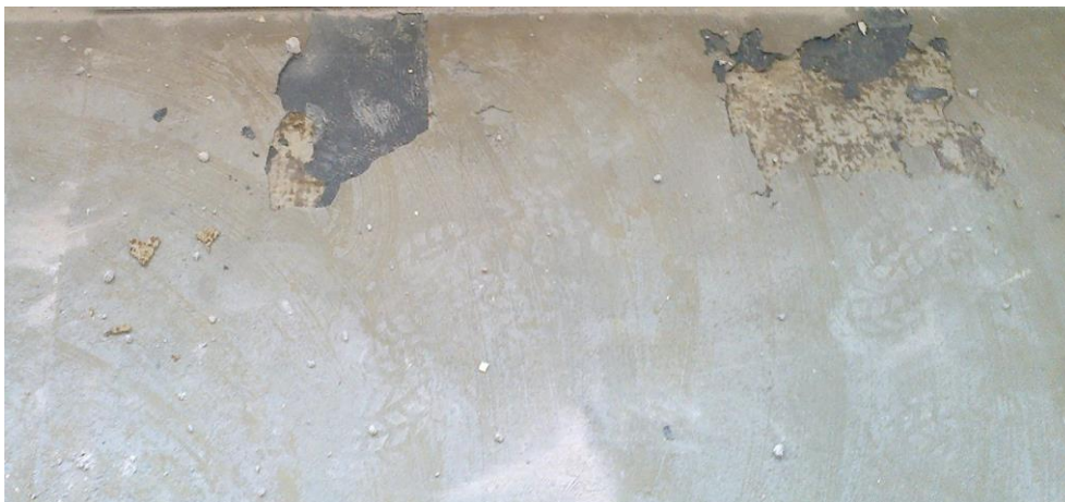
Kuva 13 Asbestipitoista mustaa liimaa
