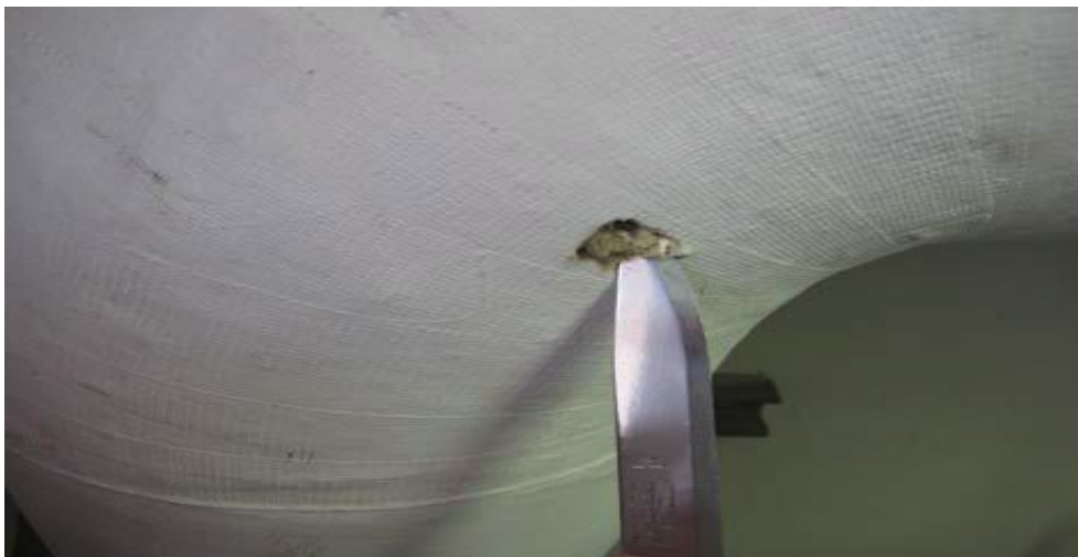
Kuva 8 Asbestipitoiset putkieristeiden mutkien massaukset
