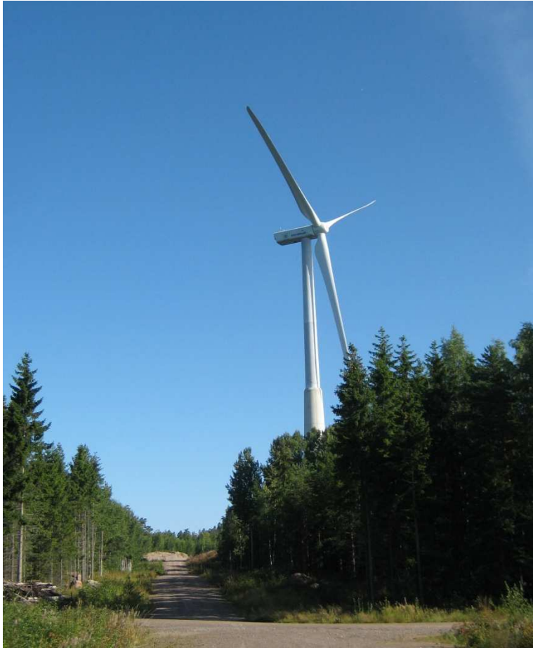
Kuva 1. Kolmilapainen aksiaalinen tuulivoimala
