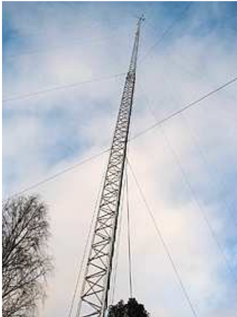
Kuva 7. Tuulenmittauksissa käytettävä masto. (17.)
