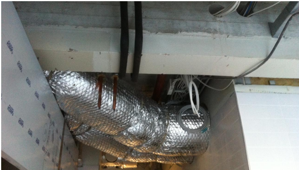
Kuva 15. Hankkeen A keittiön alakaton yläpuolisia talotekniikka-asennuksia.
