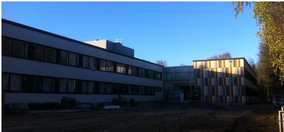
Kuva 2. Hankkeen A julkisivua uudella verhouksella.
