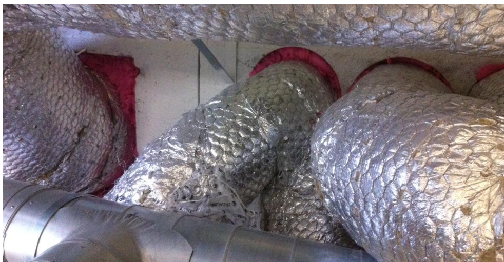
Kuva 13. Ilmanvaihtoputkien läpivientien täyttöjä palokatkon kohdalla.
