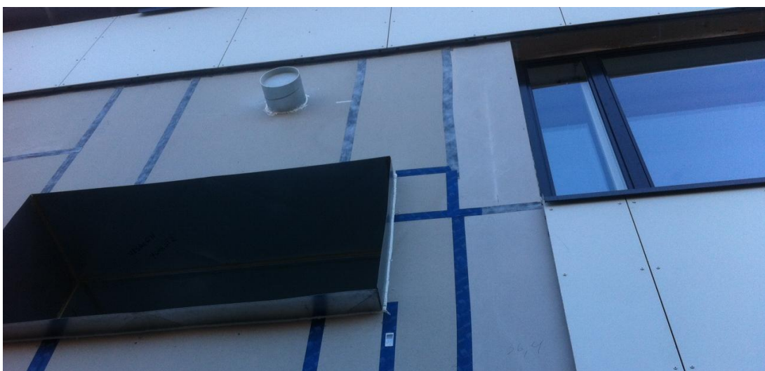
Kuva 11. Ilmanvaihtosäleikön asennuspaikka julkisivussa.
