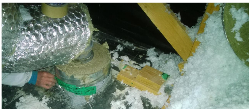
Kuva 18. Palokatkon jälkikorjaustyö hankkeessa B.
