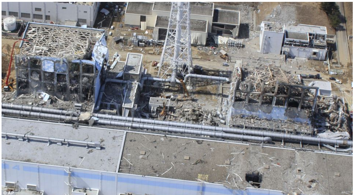
Kuva 1. UAV:n ottama kuva tuhoutuneesta ydinlaitoksesta
