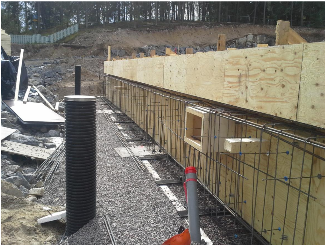
Kuva 4. Muottivälikkeet paikallaan ja rauditus käynnissä.
