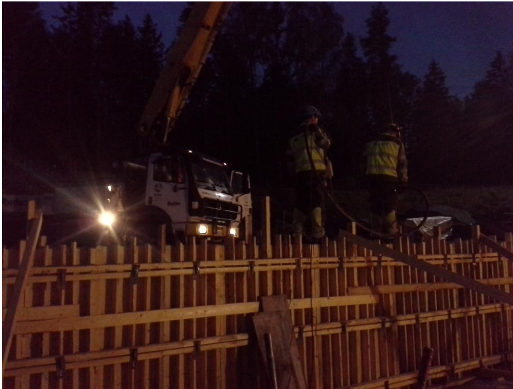
Kuva 6. Sokkeleiden valua illalla.
