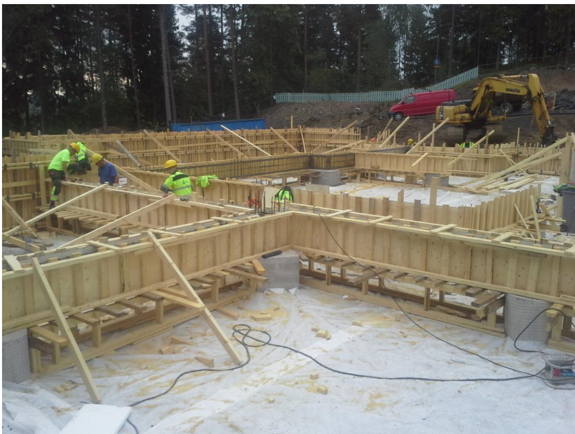
Kuva 3. Pohja suojattu suodatinkankaalla.
