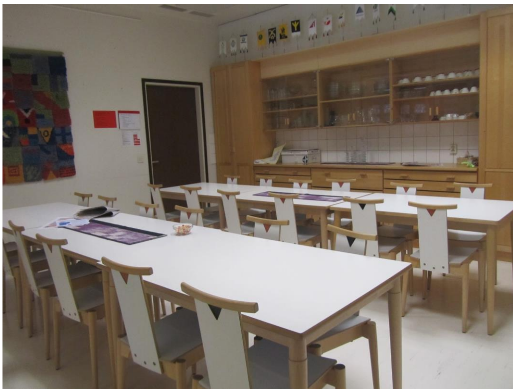
KUVA 7. Henkilökunnan tila ennen (Kempas 2014-02-05.)
