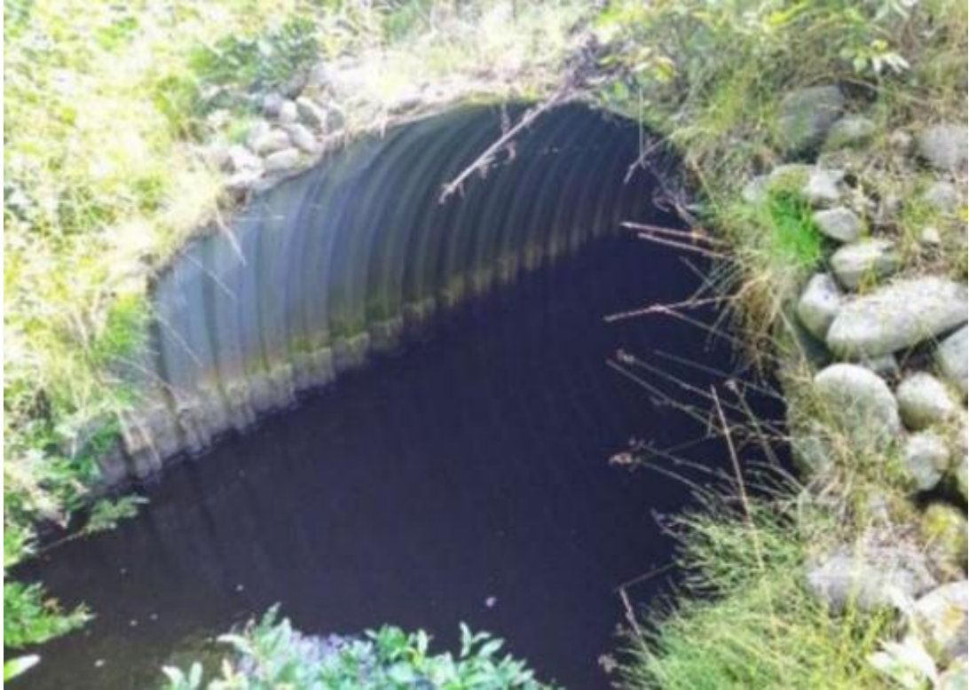
Kuva 5. Teräsputkisilta (Sakari Seppälä).
