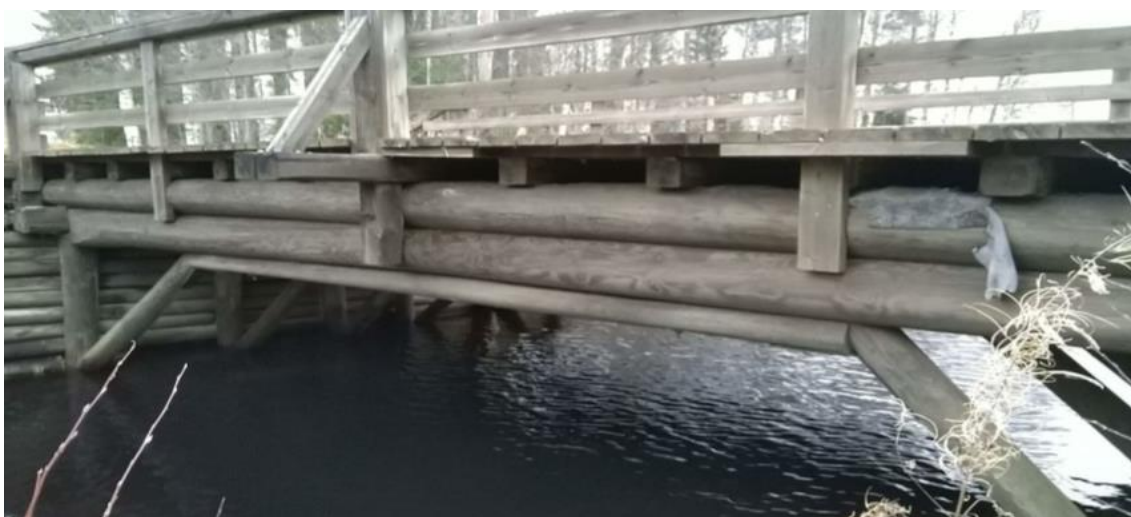
Kuva 4. Ansas-tukkisilta (Teuvo Taura).
