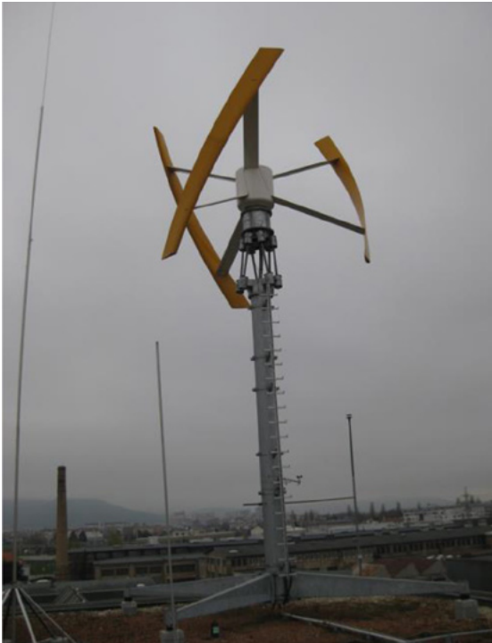
Kuva 12. Energy Basen katolla oleva tuulivoimala 5 kW
