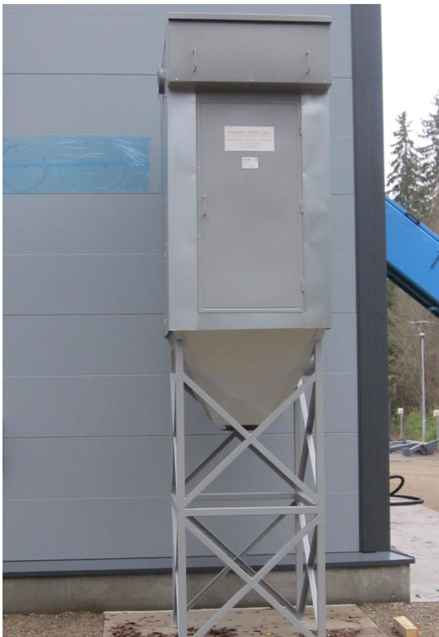
KUVA 7. Letkusuoitin (kuvasta puuttuu keräyssuppilo, johon savukaasusta erottuneet hiukkaset tippuvat)
