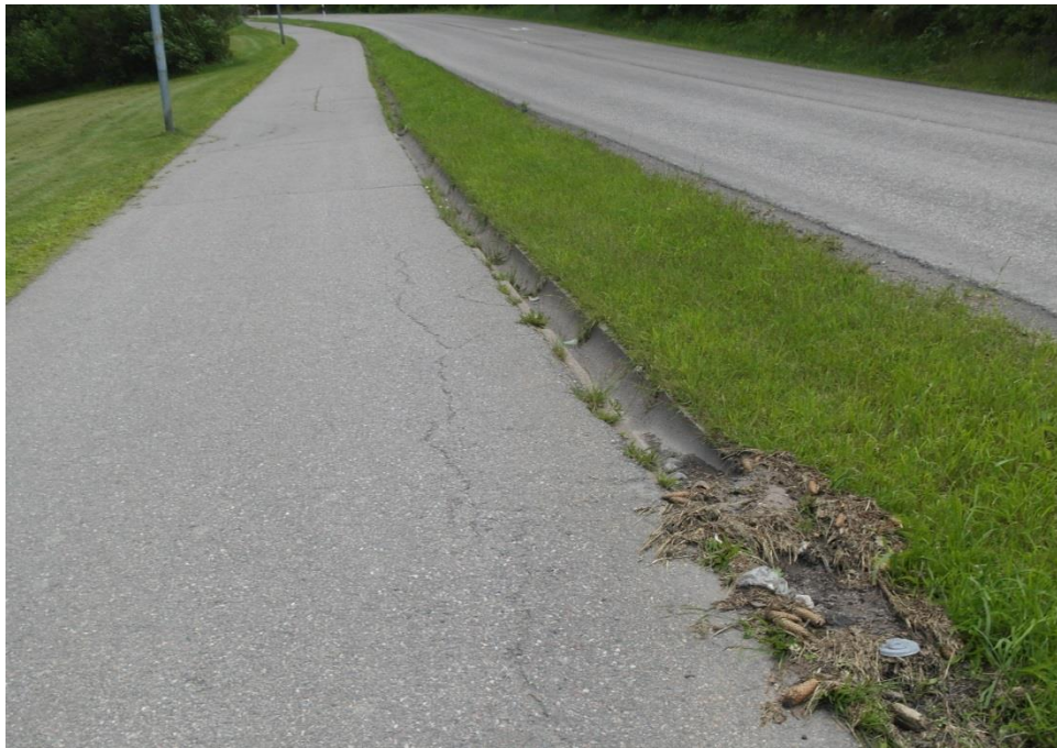
Kuva 62. Bembölientien Kaunialan sairaalan vieritse kulkevan yhdistetyn jalankulku- ja pyörätien kohta, jossa kasvillisuus on tukkinut sadevesikourun paikoitellen kokonaan.
