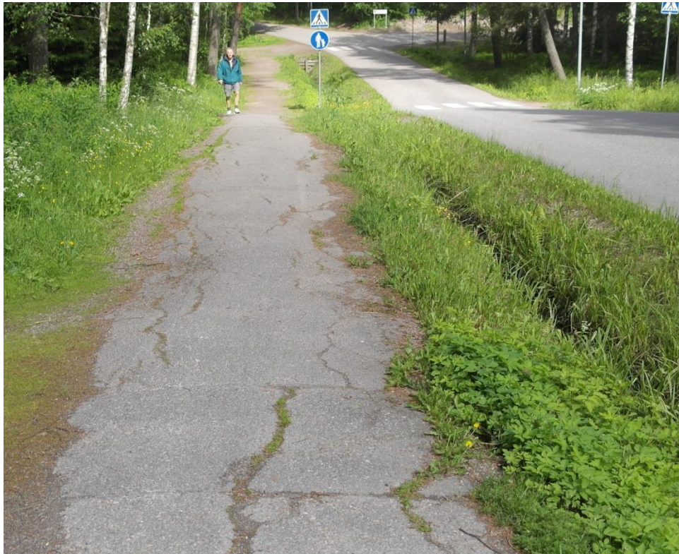
Kuva 46. Oppilaskodintien yhdistetty jalankulku ja pyörätie Eteläiseltä Suokujalta eteenpäin.
