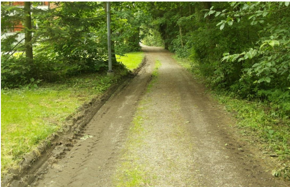
Kuva 51. Forsellesintieltä päiväkodin vieritse kulkeva puistokäytävä on puutteellisessa kunnossa
