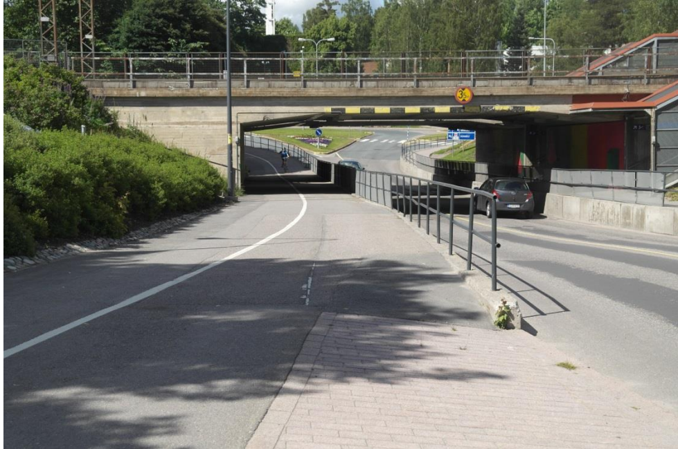
Kuva 34. Tunnelitien erotettu jalankulun- ja pyöräilyn väylä
