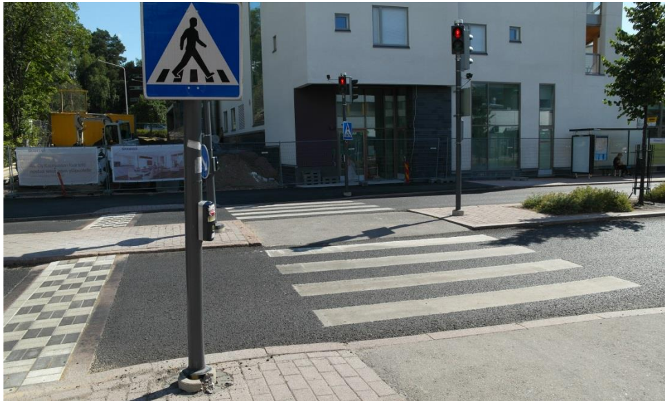
Kuva 36. Tunnelitien ylityspaikan painonappi on liian kaukana ylityspaikasta. Liikennevalokojen pylväs tulisi sijoittaa samaan linjaan suojatien reunaan ja suojatie merkki kääntää oikein päin.
