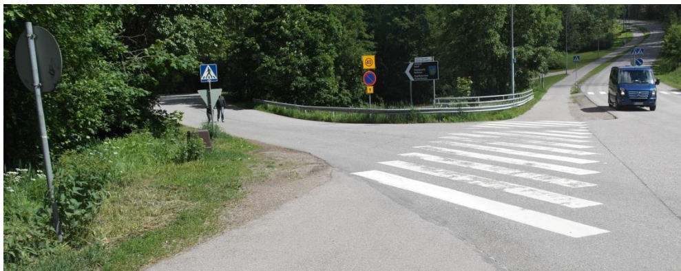
Kuva 58. Bembölentien ja Vanhan Turuntien risteys. Vanhan Turuntien kärkekolmio ja suojatiemerkki ovat väärässä paikassa, aivan liian kaukana itse risteyksestä ja suojatiemerkki on väärinpäin. Toiselta puolelta merkki puuttuu kokonaan ja yhdistetyn jalankulku ja pyörätien ilmoittava merkki on aivan kasvillisuudessa sekä liian matalalla.
