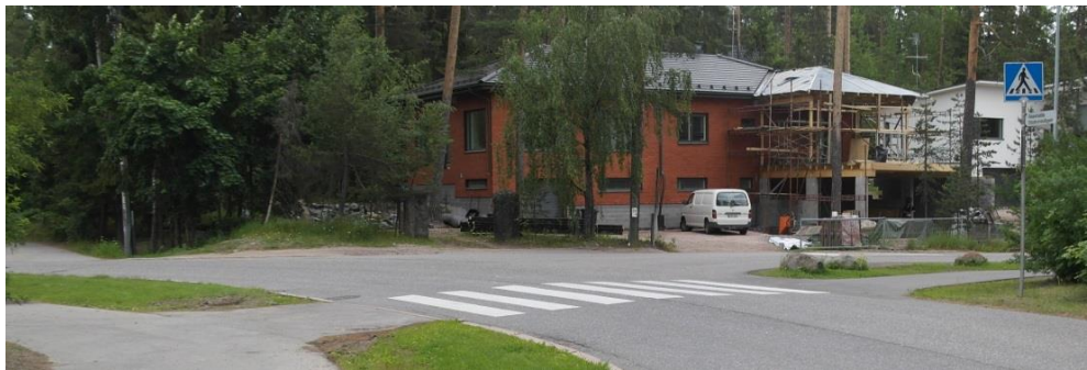
Kuva 57. Asematien ja Vanhan Turuntien risteys, toiselta puolelta suojatiemerkki (511) puuttuu ja toisella puolella se on väärinpäin.
