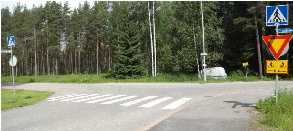
Kuva 56. Kasavuorentien ja Mikael Lybeckin tien risteuksen suojatiemerkit ovat molemmat väärinpäin ja vasemmalla puolella merkki on väärin sijoitettu.
