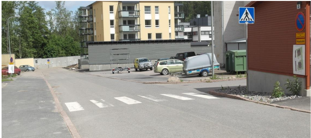
Kuva 59. Venevalkamantie 3:n kohdalla oleva suojatie, joka vie suoraan autokatoksen seinään. Suojatie on käytännössä aivan turha ja vaikka se olisikin toiminnassa, niin silti tien vasempaan reunaan kuuluisi suojatiestä ilmoittava merkki. Kyseessä oleva suojatie tulisi poistaa.
