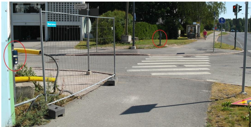
Kuva 39. Laaksotien pohjoinen ylitys, jossa kaikki painonappi-ilmalaitteet ovat aivan väärissä paikoissa (punaiset ympyrät). Selvennyksenä rakennustyömaan vuoksi pylväitä ei ole siirretty, vaan ne ovat alkujaankin sijoitettu täysin väärin paikkoihin.
