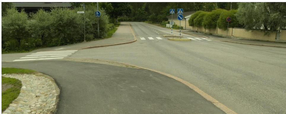
Kuva 41. Kauppalantie ja Yhtiöntien risteys
