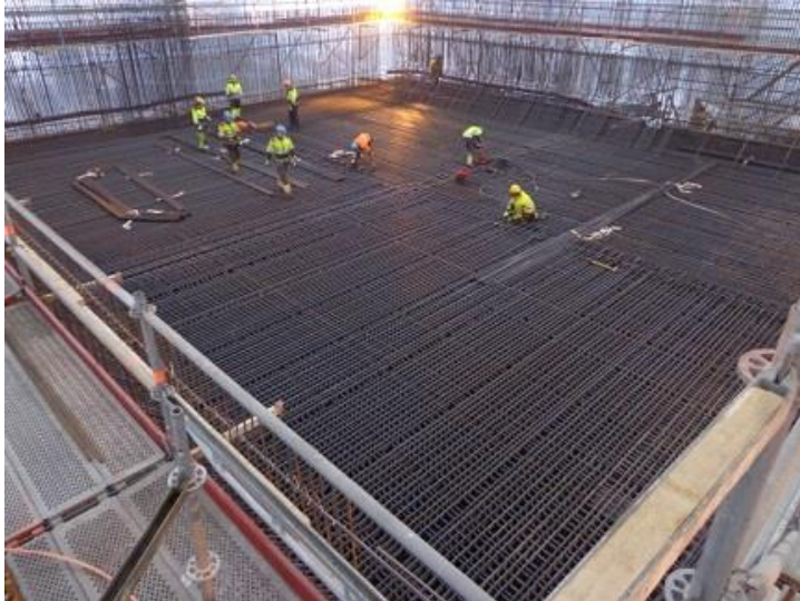
Kuva 18. Pohjalaatan raudoitusta (Tammervoiman www-sivut).
