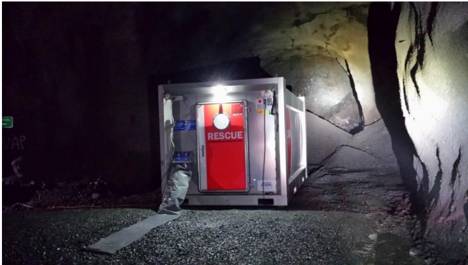
Kuva 2. Suojatila käyttöpaikassaan kaivoksessa. (Heat-It Oy, 2014.)
