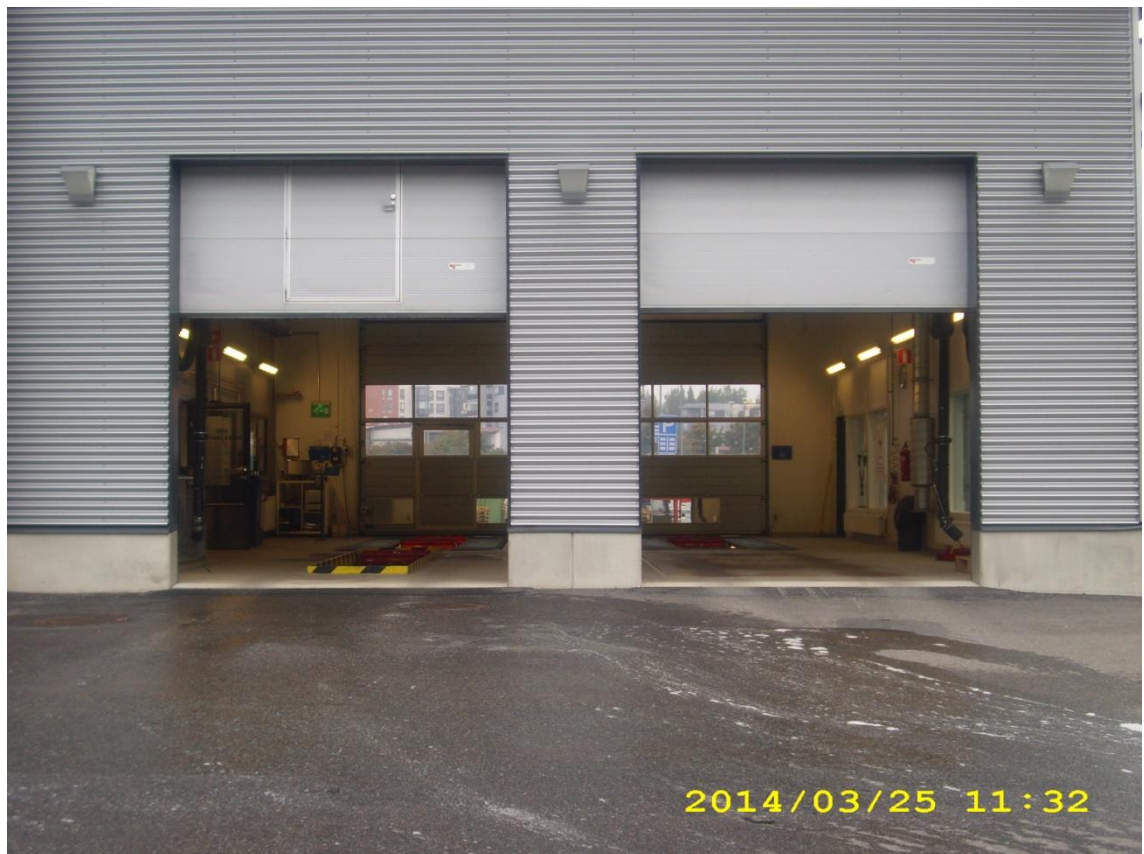
KUVA 3. Korjaamolinjasto katsastuskonttorin oikeanpuoleisella läpimenolinjastolla
