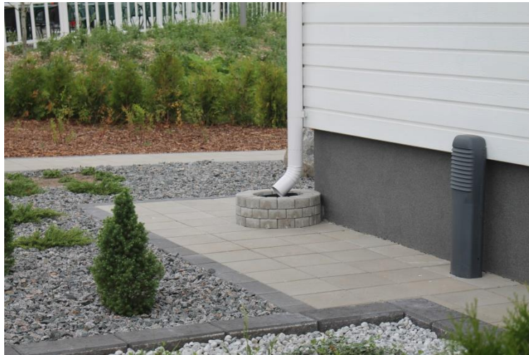
Kuva 4. Hulevedet ohjataan rännistä hulevesiviemäriin.
