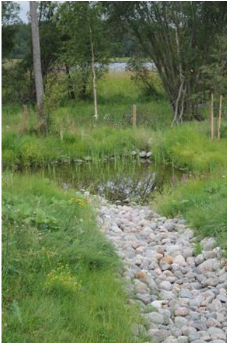
Kuva 29. Hulevesiallas hulevesiuoman päässä
