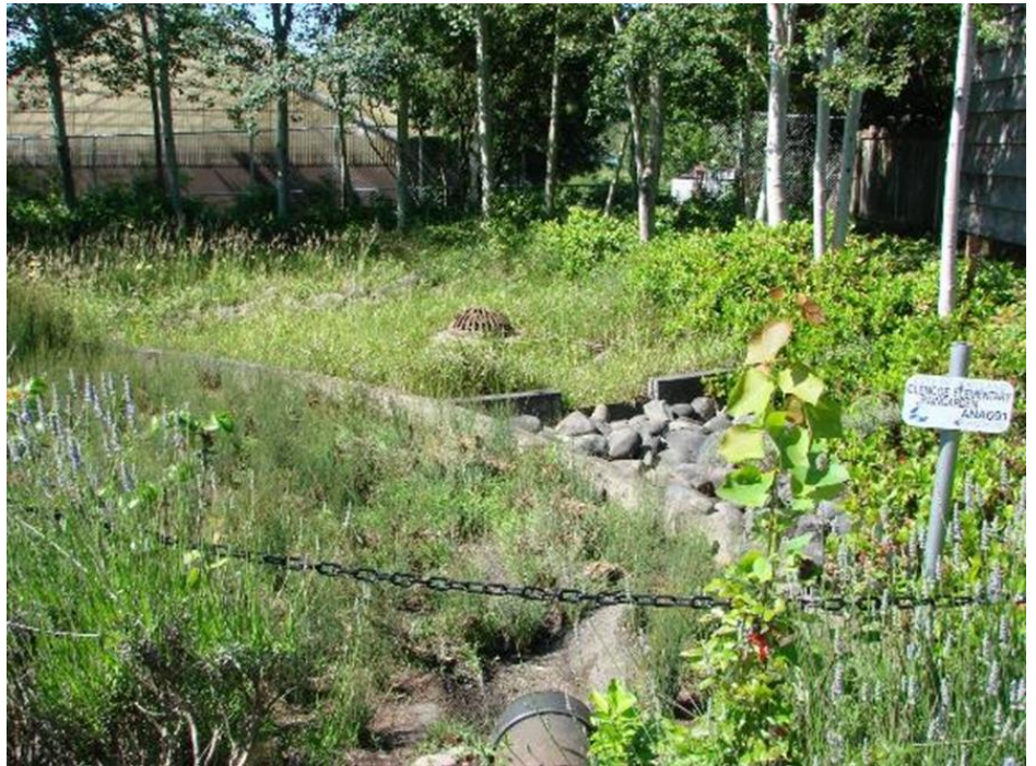
Kuva 24. Portland, Glencoe elementary school, sadevesipuutarha (Katja Virtanen, 2014). Kuvassa etualalla on sadeveden tuloputken pää ja keskellä ylävuotoviemäri (tulvareitti).
