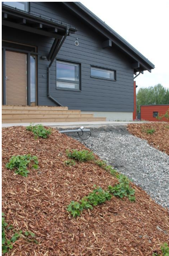
Kuva 17. Tontin reuna on luiskattu istutusalueella ja murskepinnalla.
