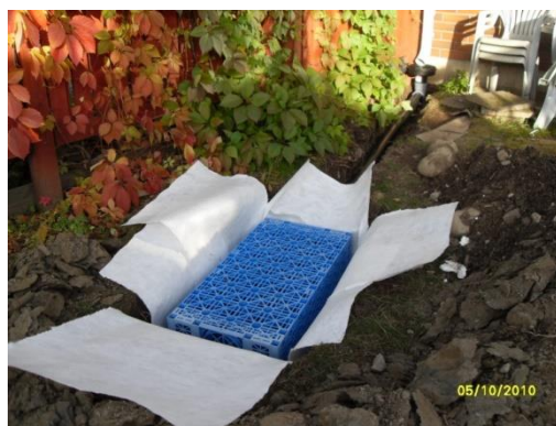
Kuva 34. Hulevesikasetin asentaminen pientalon pihaan.
