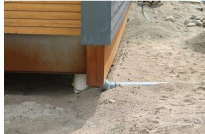
Kuva on rakentamisen aikainen kuva. Talon sadevesiputkisto tulee kokonaisuudessaan jäämään näkymättömiin.
