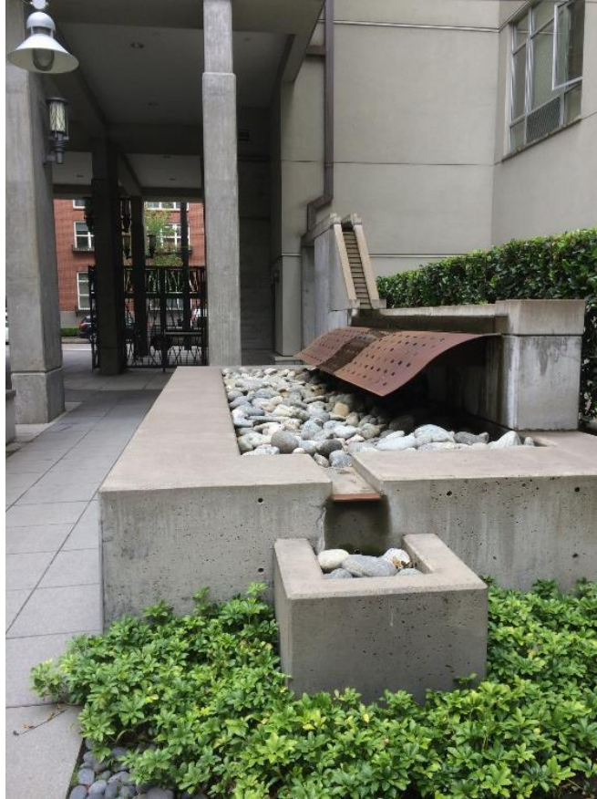
Kuva 22. Mielenkiintoinen piharakenne on samalla hulevesien ohjaus- ja viivytysmenetelmä. (kuva Katja Virtanen)
