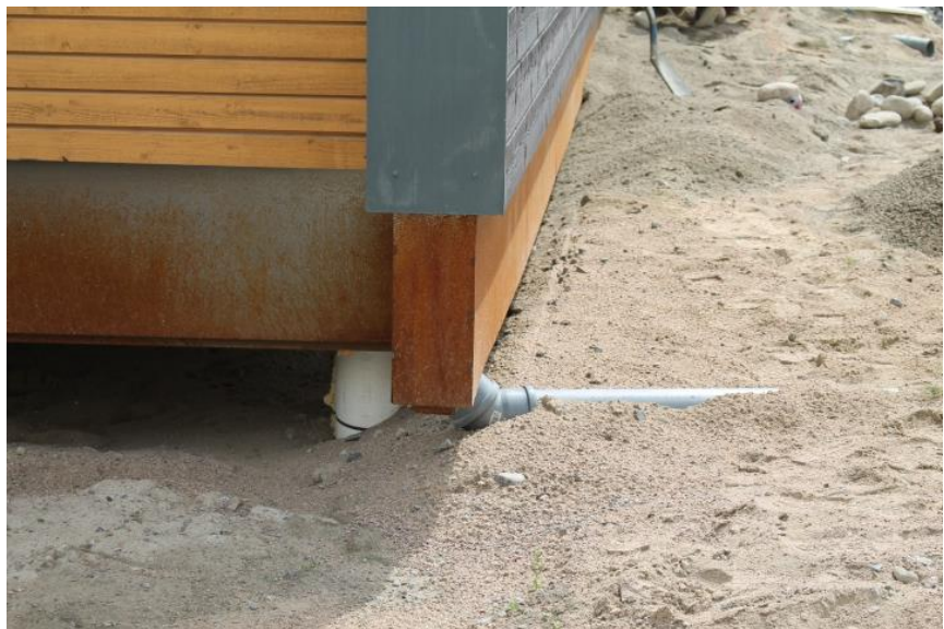
Kuva 21. Kuva on rakentamisen aikainen kuva. Talon sadevesiputkisto tulee kokonaisuudessaan jäämään näkymättömiin.
