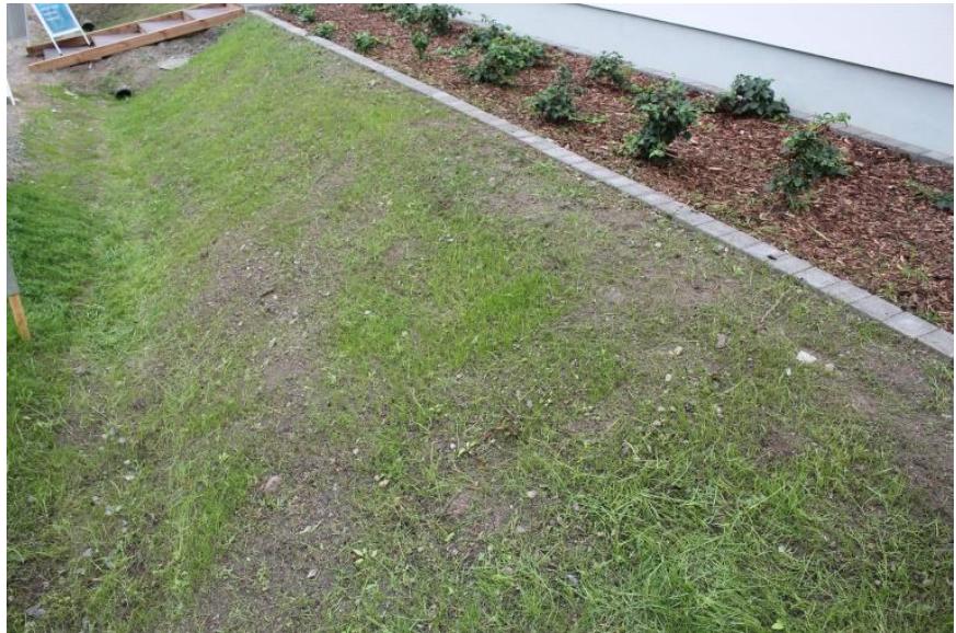
Kuva 20. Hulevedet johdetaan talon viereltä perinteisessä avo-ojassa.
