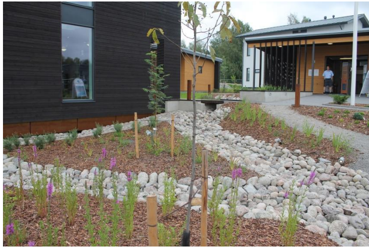
Kuva 1. Kivetyt hulevesiuomat johtavat tontilla katto- ja pintavesiä.
