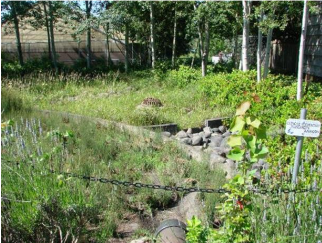
Portland, Glencoe elementary school, sadevesipuutarha (Katja Virtanen, 2013). Edessä sadeveden tuloputken pää ja keskellä ylävuotoviemäri (tulvareitti).
