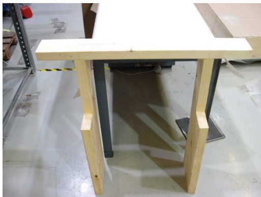
Kuva 17. Runkotolpat 48 x 248 ja ohjauspuu 48 x 123
