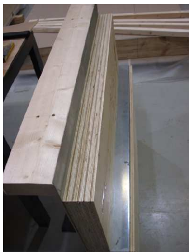
Kuva 18. Kehäpalkin, peltiprofiilin ja runkotolppien liitos
