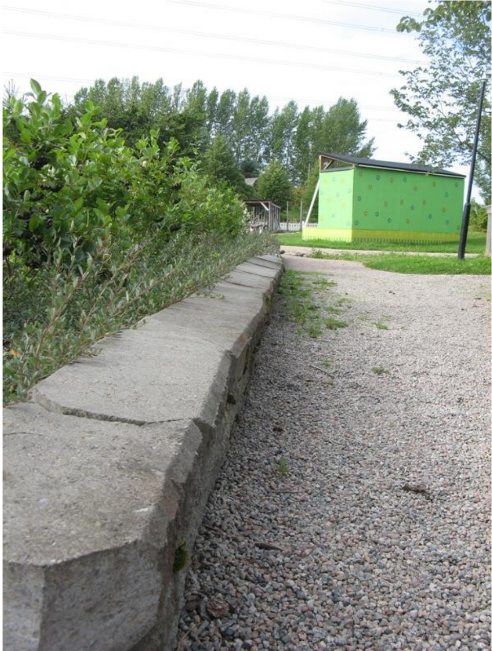
KUVA 26 Labyrintin kallistunut istutusallas (Minna Hiekkola 2010)
