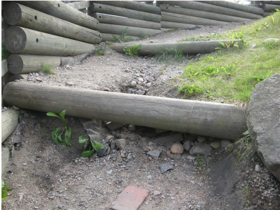
KUVA 22 Vesieroosion rikkomat portaat Seikkailupuistossa (Minna Hiekkola 2010)
