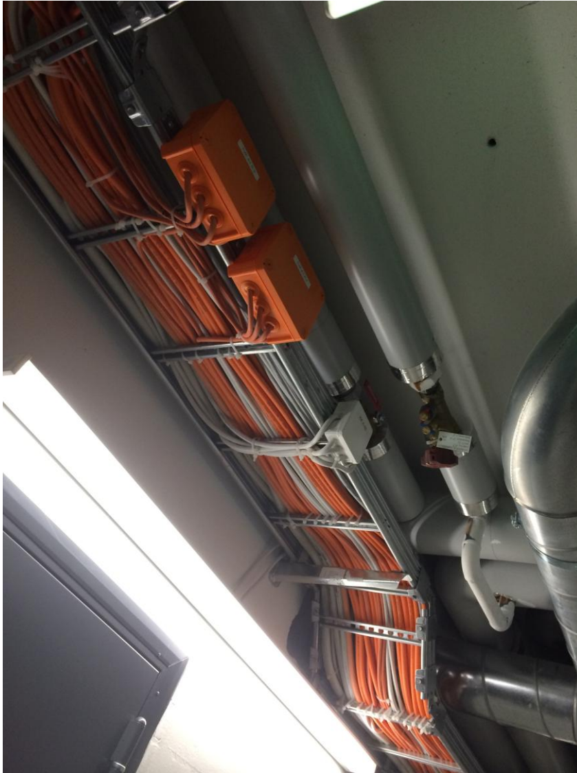
Kuva 10. Virheellisesti asennetut paloturvallisuuskaapelit ja jakorasiat.
