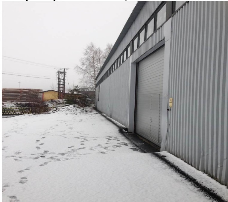
- Kuva 4. Luoteisseinustalla nosto-oven kulkuluiska viettää halliin päin.
