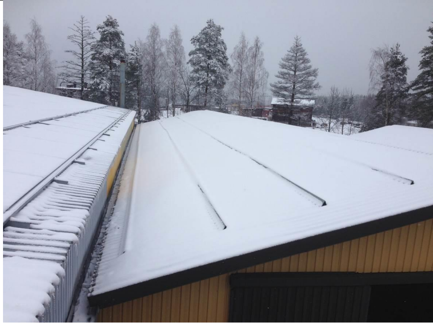
Kuva 26. Viereisin kylmän varastohallin katossa ei ole havaittavissa samanlaisia sulamiskohtia.
