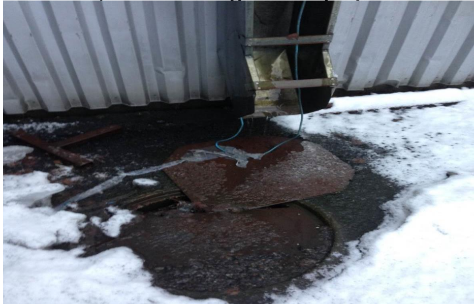
Kuva 11. Kourun alastulon vedet johdettu heikosti kaivoon, vedet pääsevät maa-
