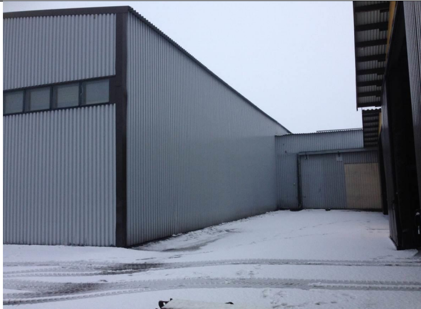
Kuva 8. Laajennuksen ja vanhan osan nurkkaus. Maanpinnan kallistukset puutteelliset, nurkka erittäin kostea.
