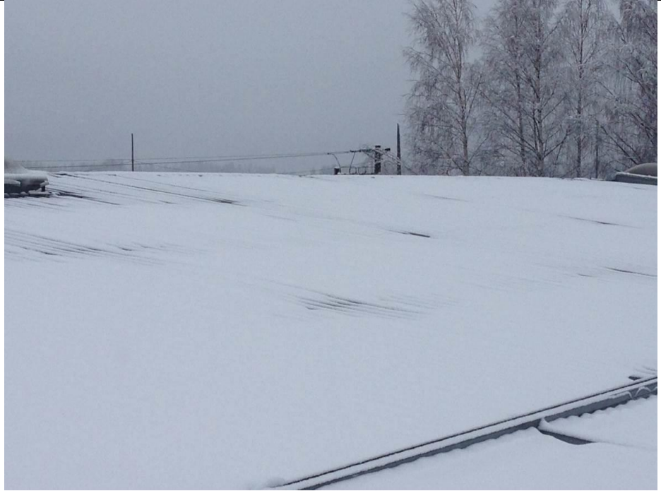
Kuva 24. Katon lumipeitteessä sulamisesta aiheutuneita laikkuja, oletettavasti lämpövuotojen aiheuttamia.
