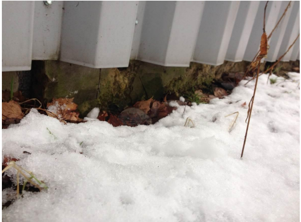
Kuva 15. Koillisseinän seinäpellin alta maahan on tippunut tuulensuojalevyä tai eristettä, jossa on selvästi vihreää mikrobikasvustoa.
