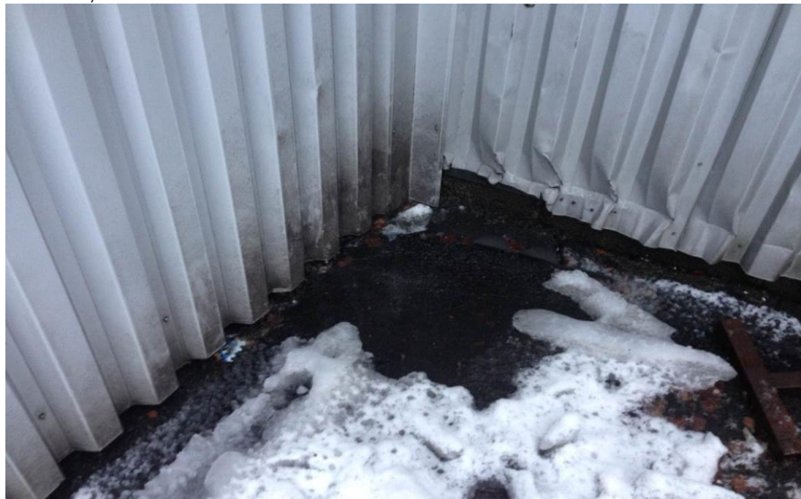
Kuva 9. Laajennuksen ja vanhan osan märkä nurkka. Sadevedet valuvat nurkkaan, kosteus on päässyt sisäpuolelle asti. Seinäpellin alareunassa tummentumaa sadevesien roiskeesta johtuen.
