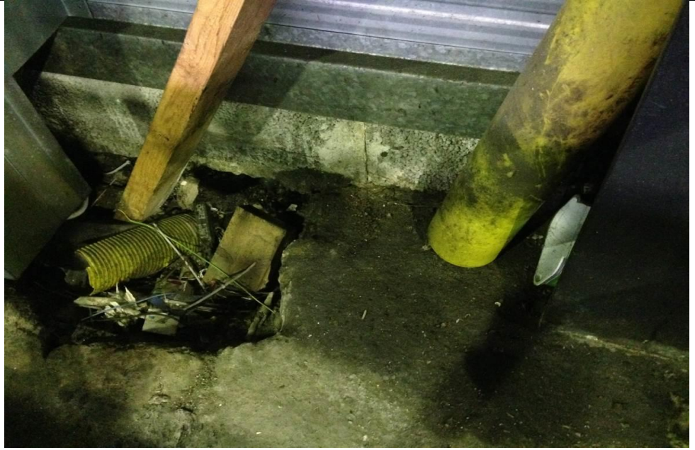
Kuva 10. Laajennuksen ja vanhan osan nurkassa kosteus on päässyt ulkoa sisäpuolelle. Lattiasa monttu, joka on täynnä jätettä.
