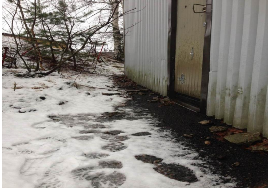
Kuva 7. Pohjoiskulmauksessa maanpinta viettää rakennukseen päin ja julkisivun alareunassa tummentumaa ja sammalkasvustoa.
