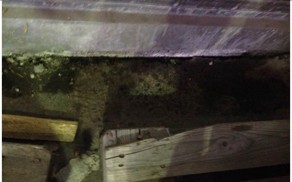
- Kuva 3. Luoteenpuoleisen sisäseinustan märkäkohta
