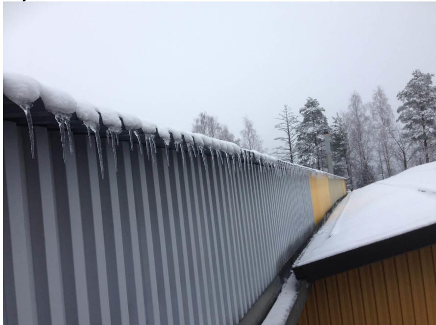
Kuva 27. Räystäälle syntyneet jääpuikot.
