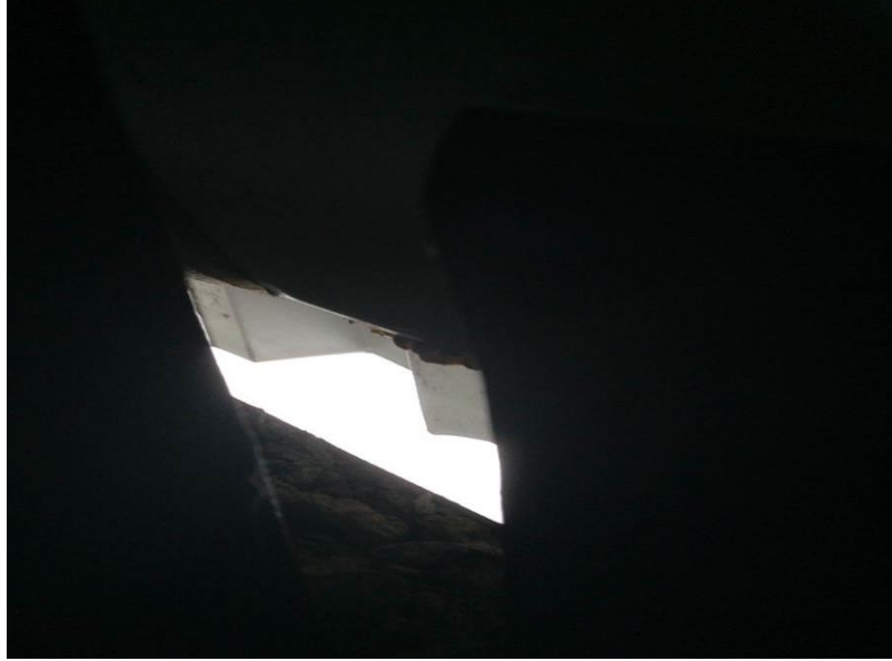
Kuva 19. Reikä rakennuksen vaipassa pilarin kohdalla.
