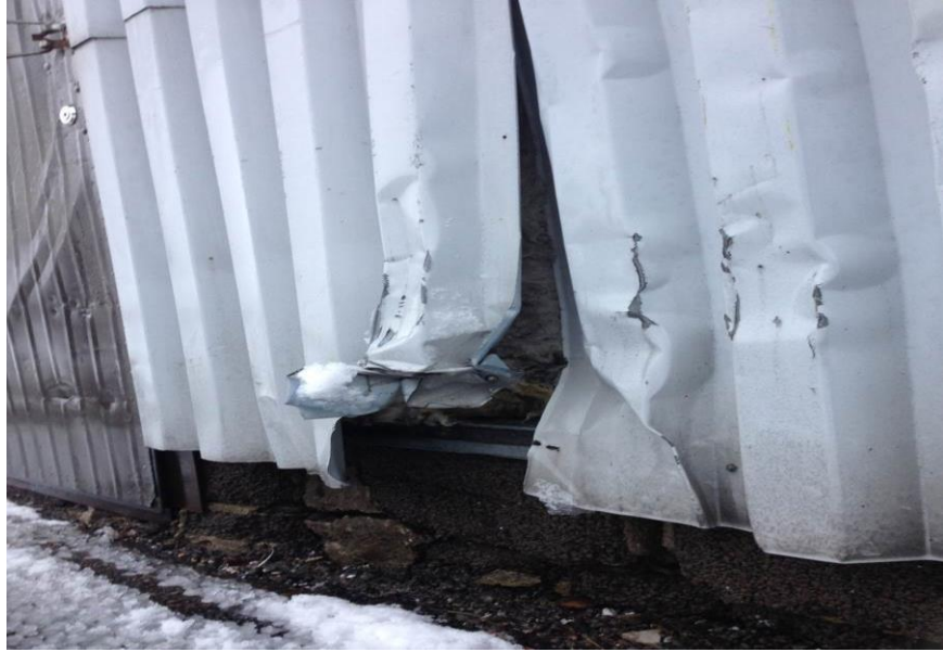
Kuva 14. Lounaisseinän pellin alareuna rutussa ja saumakohta revennyt auki. Eristeen pinnassa oli kosteutta.
