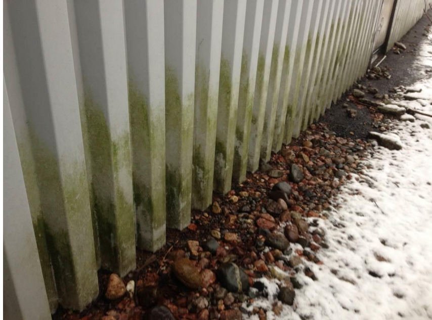
Kuva 13. Pohjoiskulmassa pellissä sammalkasvustoa.
