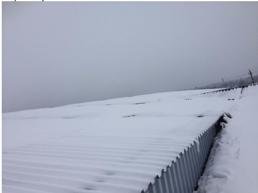
Kuva 25. Katon lumipeitteessä sulamisesta aiheutuneita laikkuja, oletettavasti lämpövuotojen aiheuttamia.
