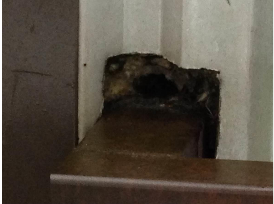
Kuva 16. Koillispäädyssä peltiverhouksen läpäisevä savupiipunputken läpiviestistä aiheutuva reikä seinän ulkopuolella.
