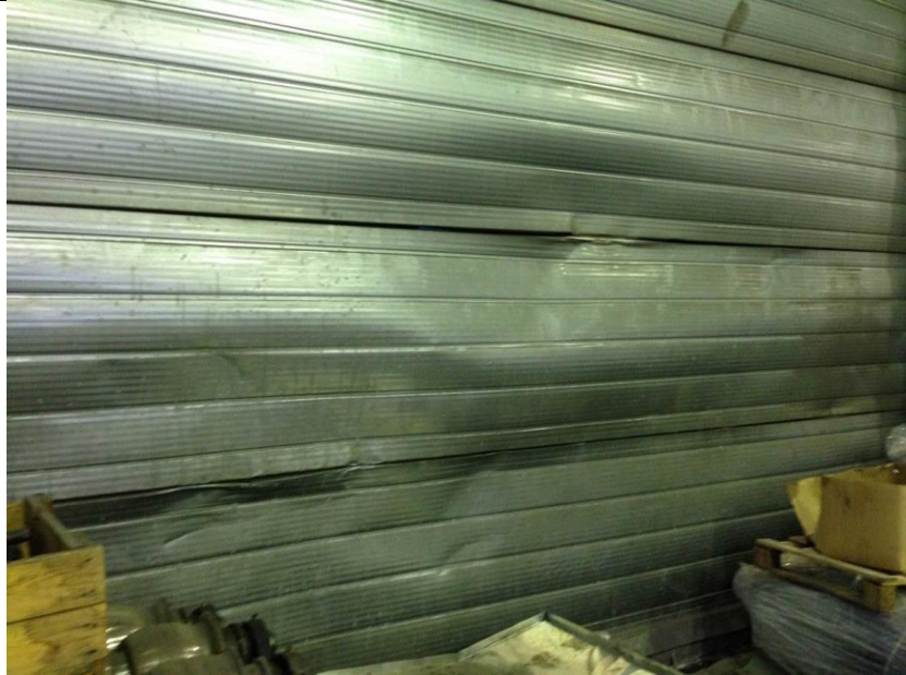
Kuva 17. Seinäkasettien kupruilua ja hammastusta.
