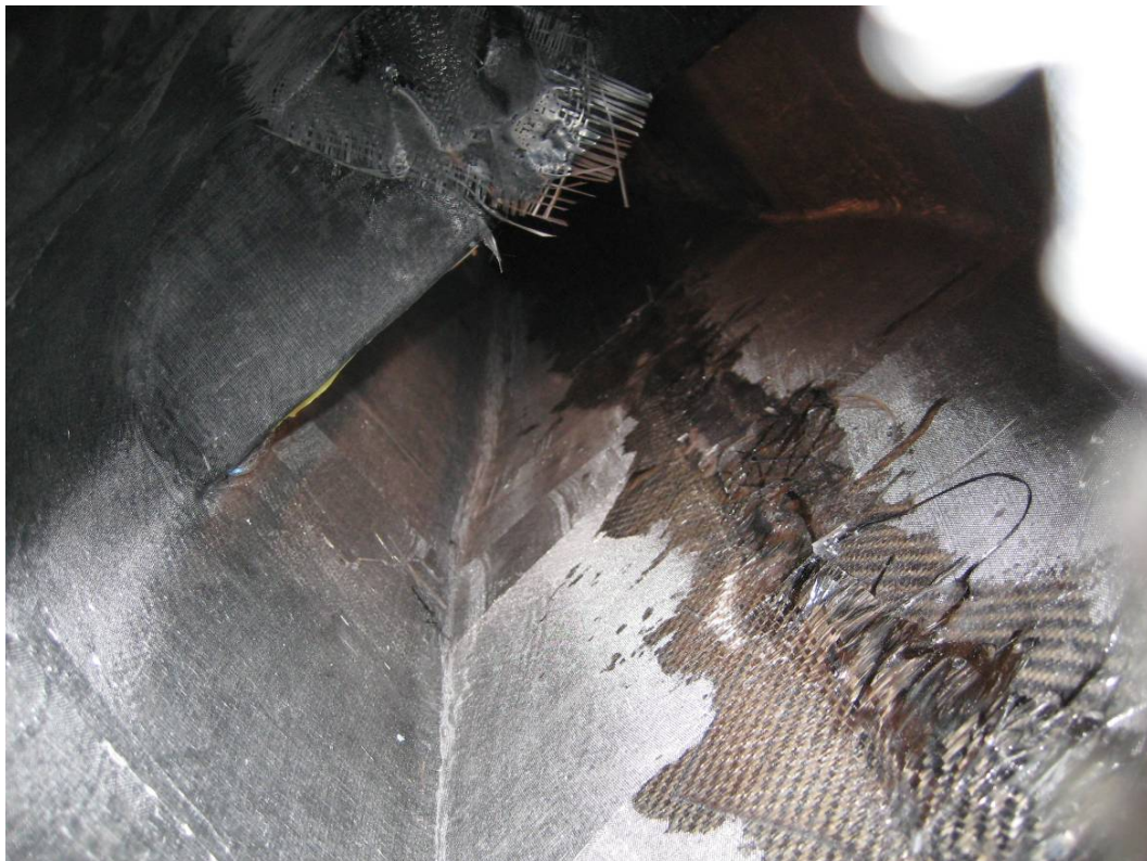
Kuva 19. Rungon keskisauma sisäpuolelta. /8/
