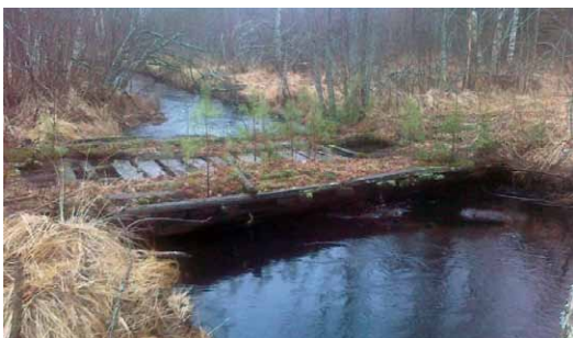
Kuva 30. Ukonnurmen alueella oleva vanha, ilmeisesti maa- ja metsätalouden tarpeita aikoinaan palvellut silta.
