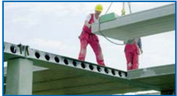
Kuva 11. Ontelolaatan pään asema deltapalkkiin nähden
