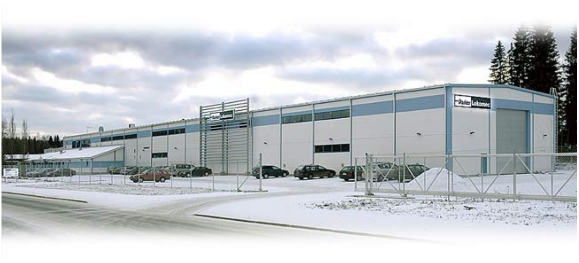
Kuva 1: Parker Lokomecin tuotantotilat Tampereen Ruskossa. ( www.lokomec.fi )
