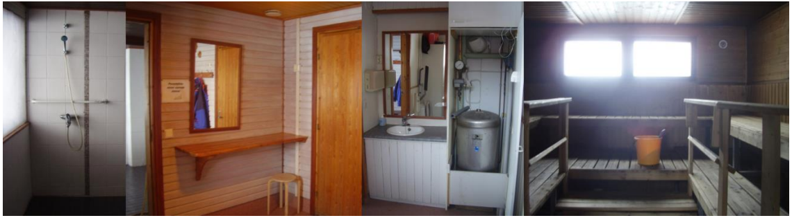
Kuva 5. Lähtötilanne saunarakennuksen peruskorjauksen suunnittelussa.
