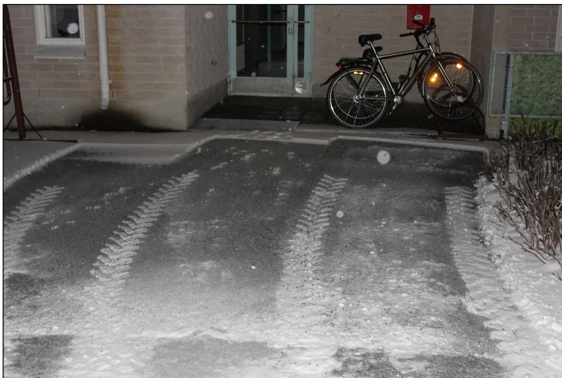
Kuva 5. Oven edusta konetyön jälkeen (Kuva: Mikko Oinonen).
