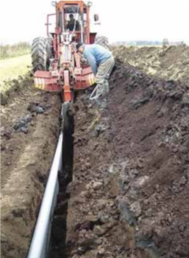
Kuva 2. Reunamuovin tarkoitus on ylläpitää pohjavesi riittävän korkealla ojan vierustan helpommin kuivuvalla alueella (Kuva Heikki Harmanen)
