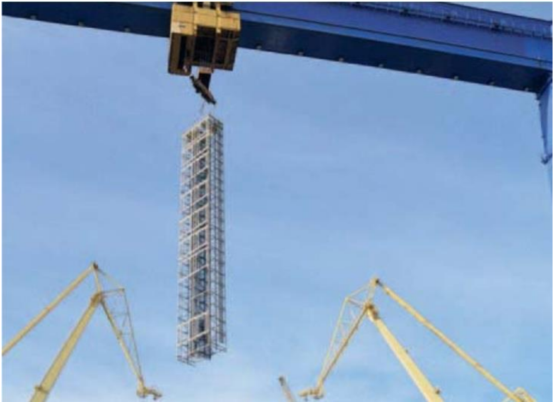
Kuva 9. Hissin nosto laivaan (KONE).
