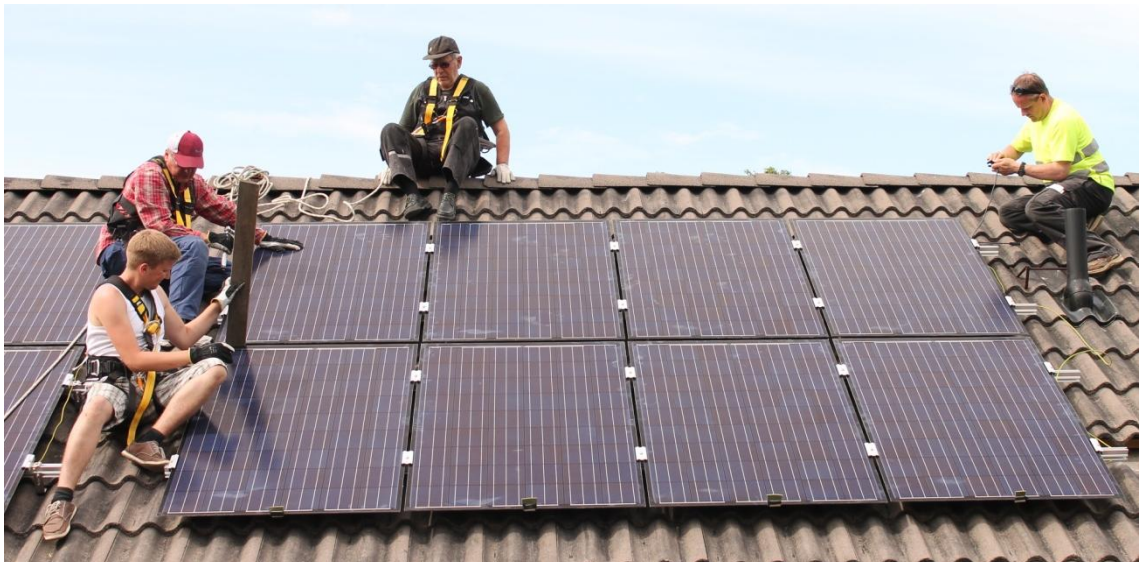
Kuva 17. Viimeisen paneelin asennus ja loppukytkennät.
