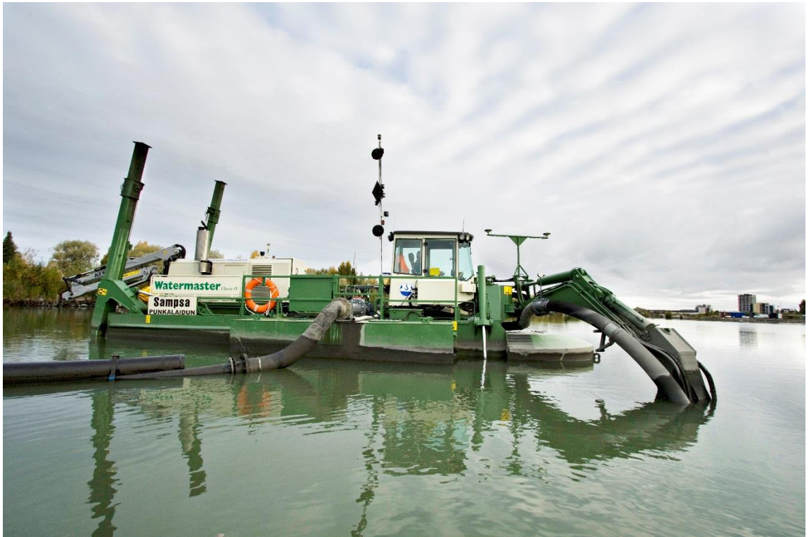
KUVA 1. Vesimestari imuruoppaus kalustolla.
