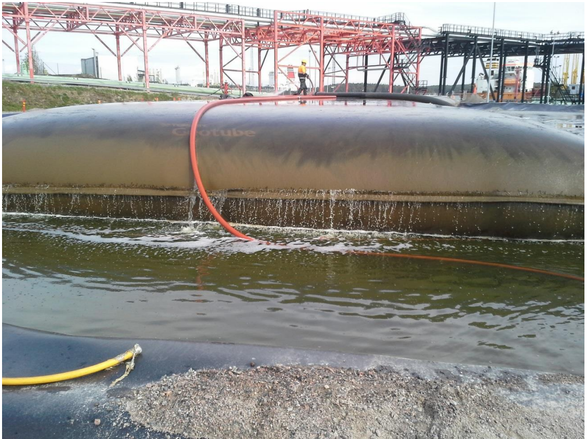
KUVA 3. Geotube –säkki toiminnassa
