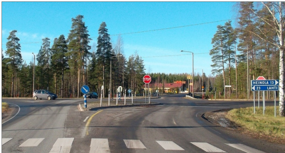
KUVA 1. Leveä turvasaareke muuttaa sivutietä ajavan ajolinjaa ja hidastaa ajonopeutta. Kuva on Heinolasta maanteiden 140, 313 ja 363 liittymästä.
