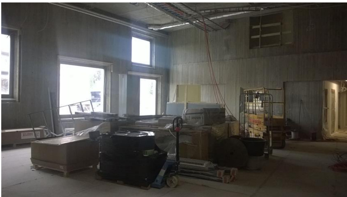
Kuva 5. Uudisrakennustyömaan varastointia sisätiloissa. (Kuva: Heidi Huvila)
