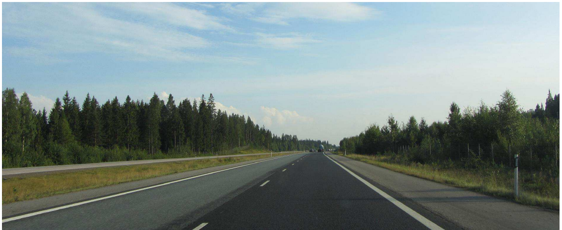
Kuva 9. Esimerkkikuva tyypillisestä N1-luokan tiestä kaiteettomalla keskialueella. [8.]
