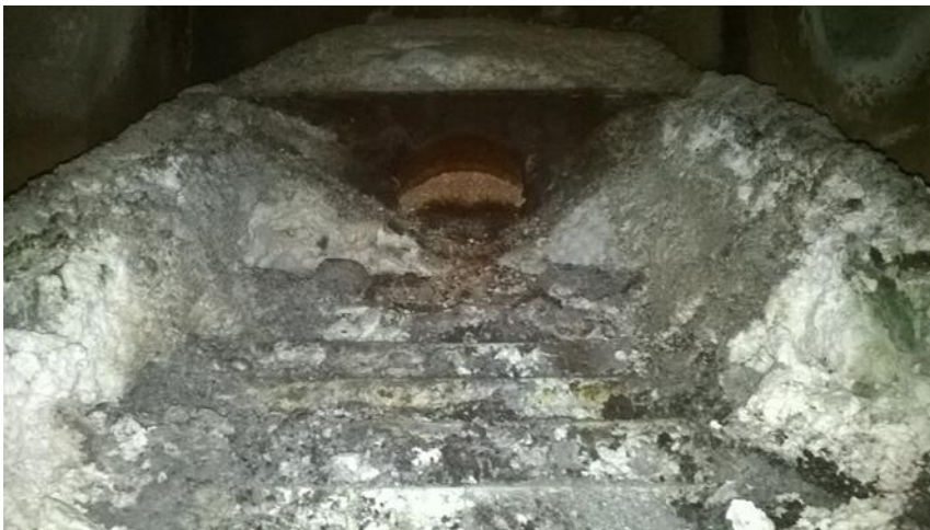
Kuva 6. Aritermin 400 kW palopää porrassarinalla on toiminut viljanpoltossa moitteettomasti. Pääosa tuhkasta siirtyy sujuvasti automaattiselle tuhkaruuville ja manuaalista tuhkanpoistoa tarvitaan vain vähän.
