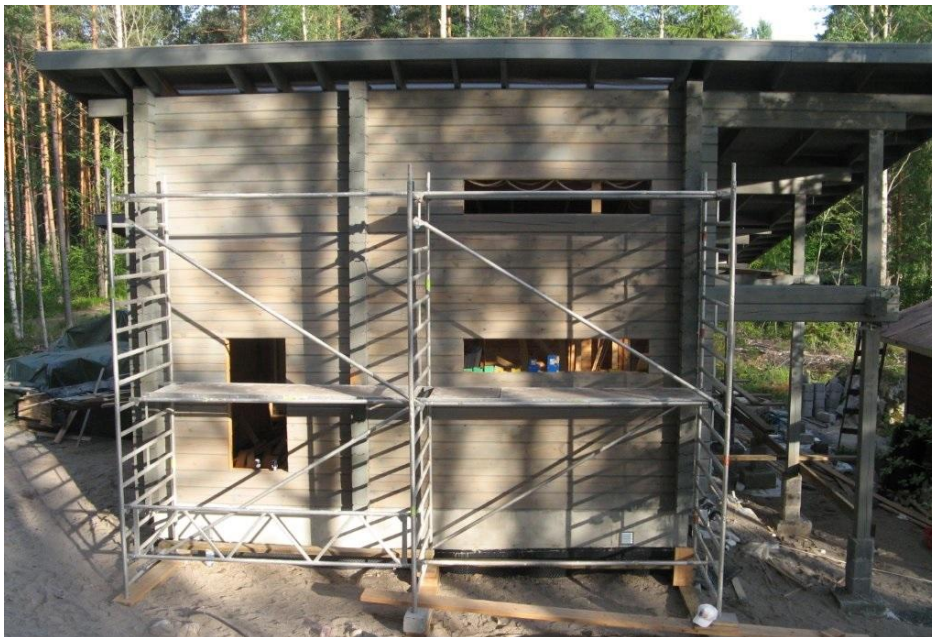
Kuva 5. Siirrettävästä telineestä puuttuu työskentelytasolta putoamissuojauksen kaitteet (Laakso 2014).
