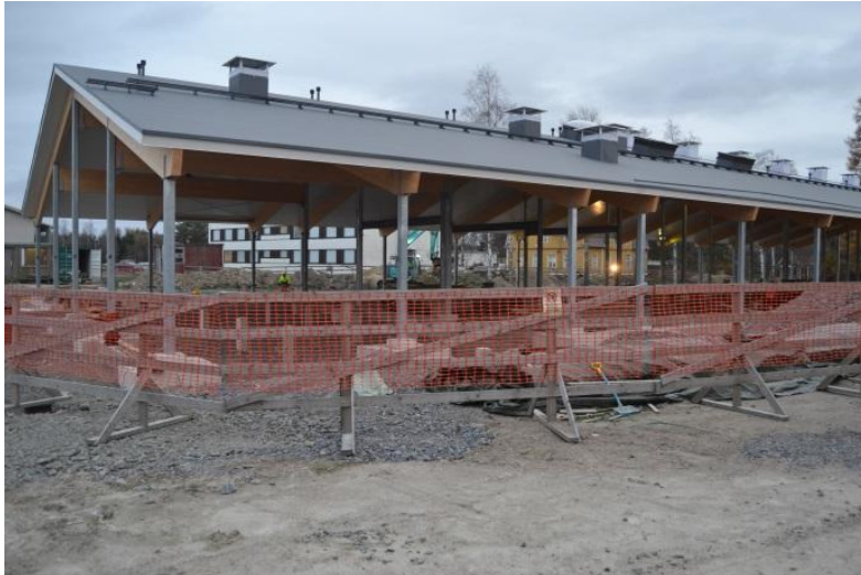
Kuva 2. Kulkuesteet navettatyömaalla Ilmajoella (Niemi 2014).
