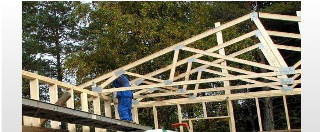
Kuva 19. Kattoristikoiden asennus
