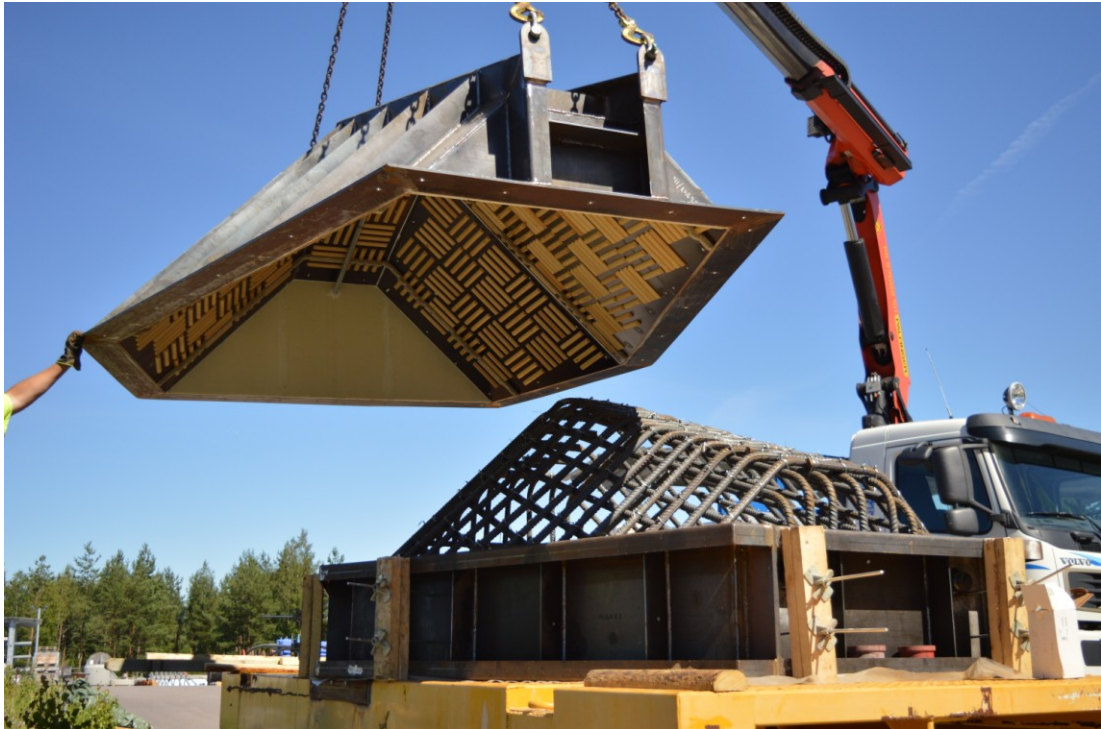
Kuva 8. Menetelmäkoe 1 muottirakenne sekä rauditus. (Posiva Oy, 2014)
