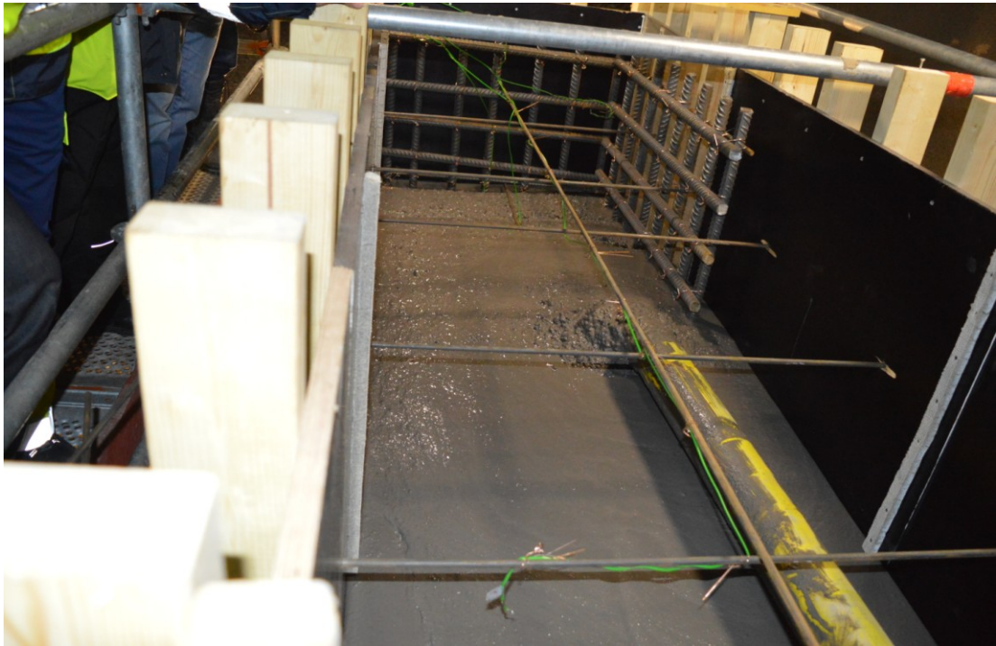
Kuva 10. Menetelmäkoe 2: Betonin pumppausta saattoputkella. (Posiva Oy, 2014)
