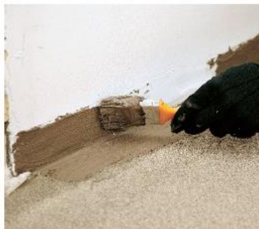
Lattian ja seinän rajakohdat tiivistetään ARDEX EP 2000 -höyrynsulun päälle ARDEX 8+9 -vedeneristeellä ja ARDEX SK 12 -vahvistusnauhalla.
