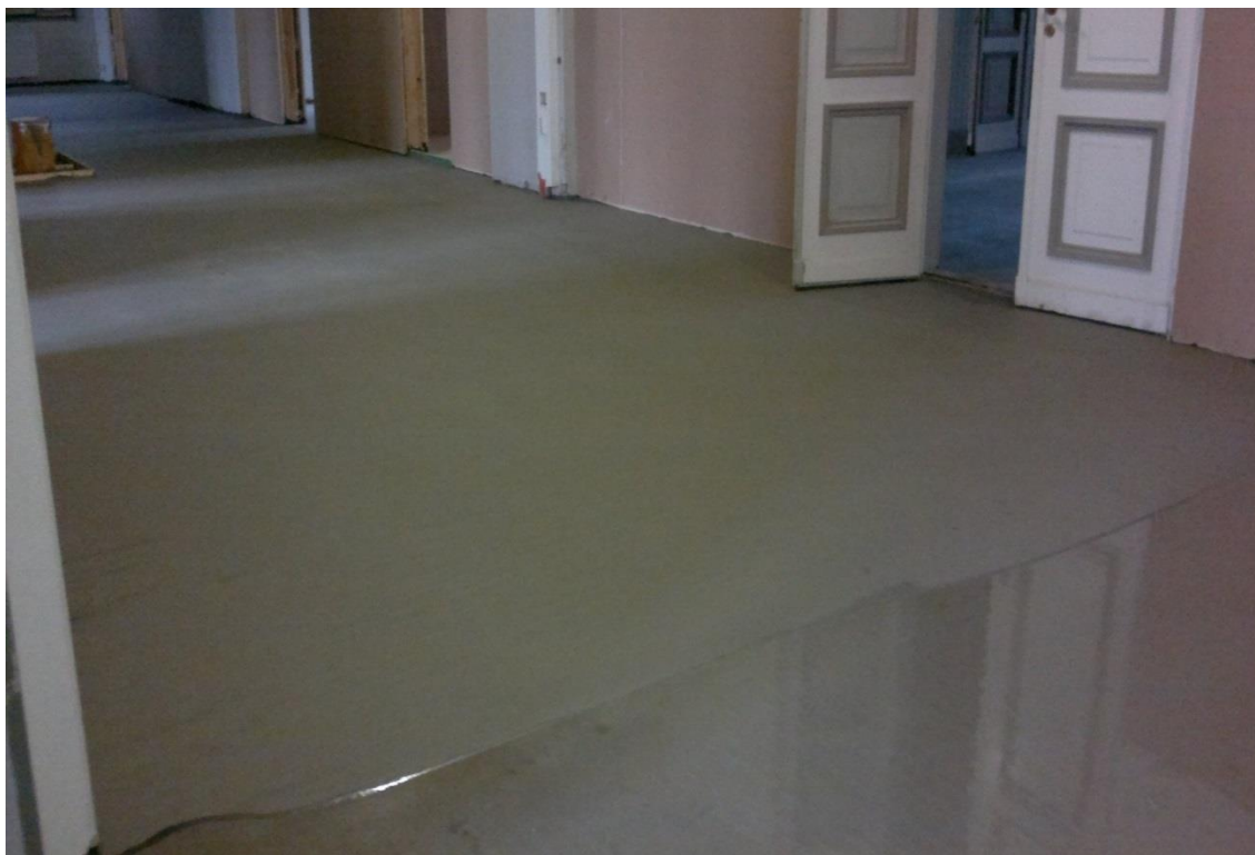
Kuva 8. Valmista plaano pintaa (Ilkka Luostarinen 2013)
