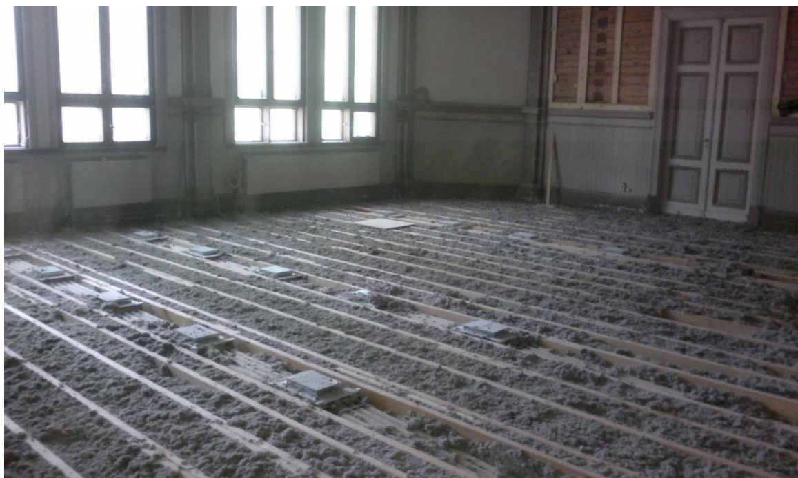
Kuva 4. Kokoustilan lattia koolauksen ja puhaluksen jälkeen (Ilkka Luostarinen 2013)
