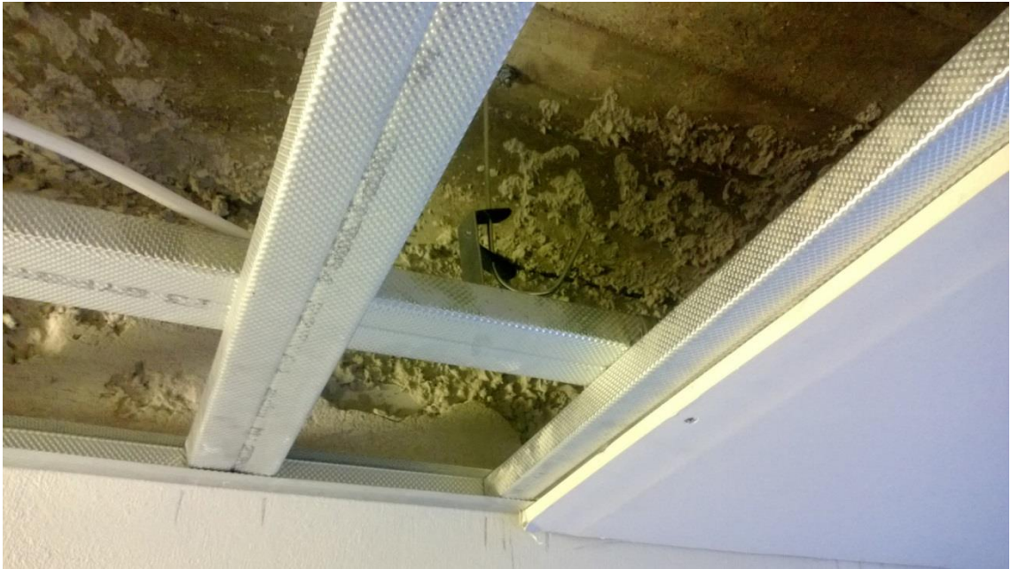
Kuva 11. Gyproc- levy alakattoa (Ilkka Luostarinen 2013)
