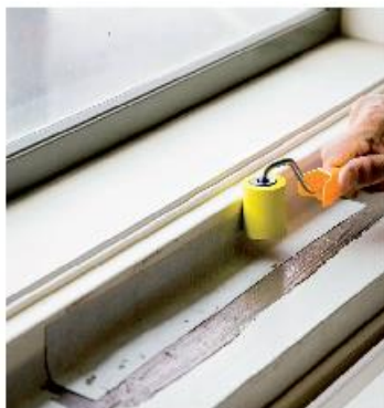
Karmiävitys tehdään sementtipohjaisella ja kutistumattomalla ARDEX 8+9 -vedeneristeellä ja ARDEX STB 75-15 -vahvistusnauhalla.
