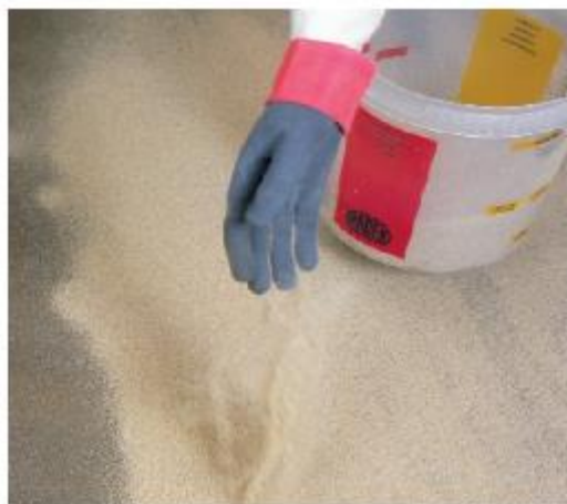
ARDEX EP 2000 on M1-luokiteltu höyrynsulku. Toiseen levityskertaan levitetään hiekka kauttaaltaan peittävästi tai välittömästi epoksin kovetettua tehdään pohjustus ARDEX P 82 -pohjustusaineella.
