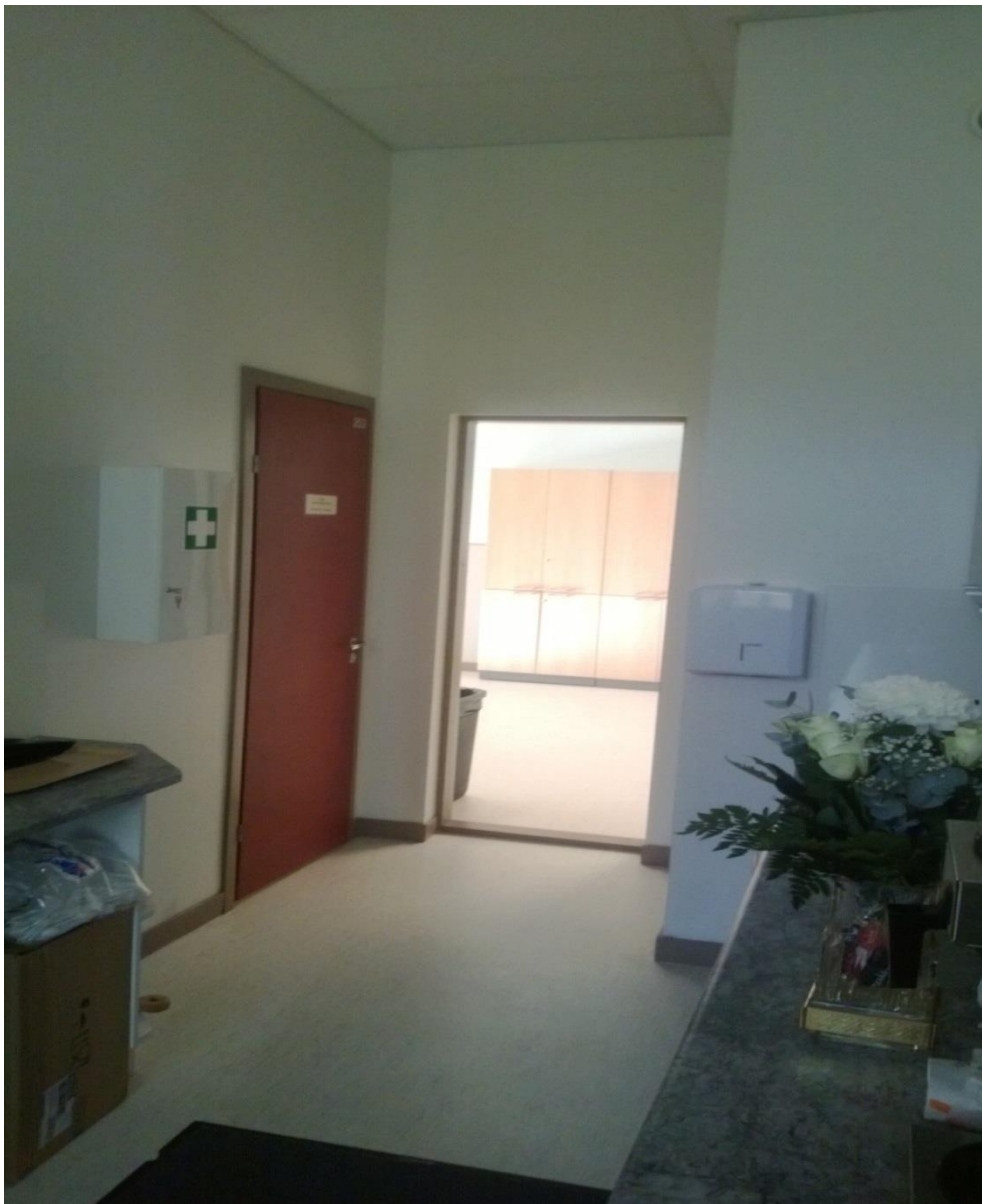
Kuva 10. Ovi asennettuna (Ilkka Luostarinen 2013)
