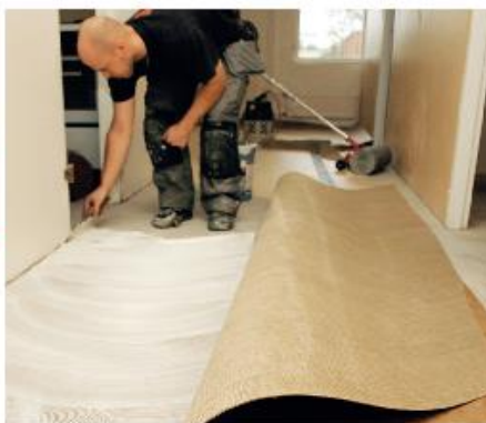
Muovipäällysteet ja linoleumit kiinnitetään ARDEX M1-luokitelluilla päällystelimoilla.
