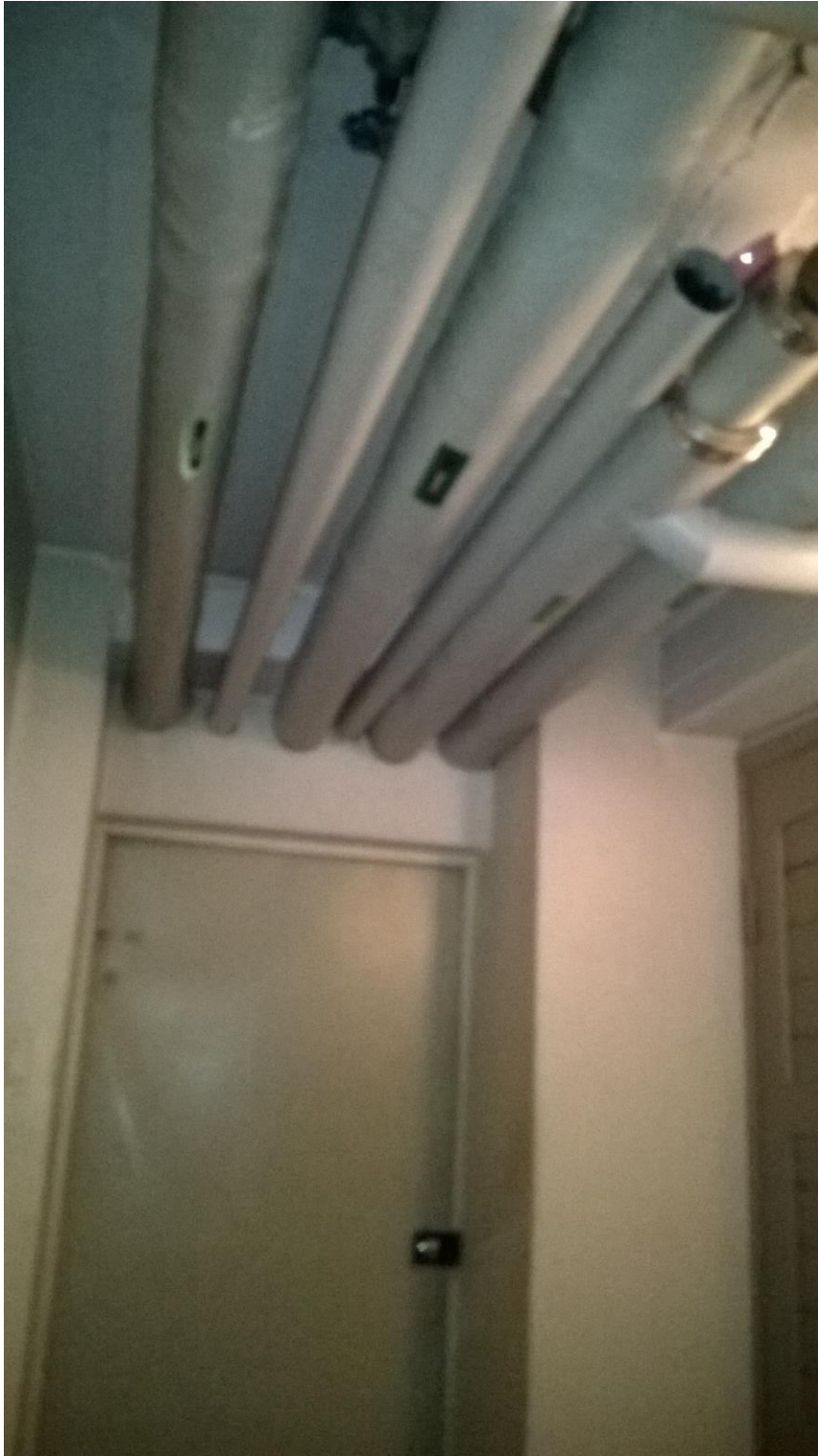
Kuva 8. Läpivientejä oven yläpuolella
