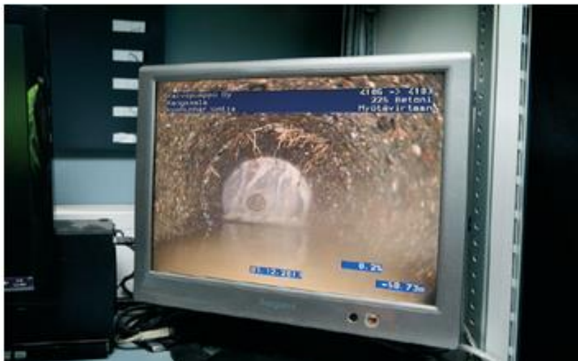
Kuva 5. Kuva viemäristä. (Kaivopumppu www-sivut 2015)
